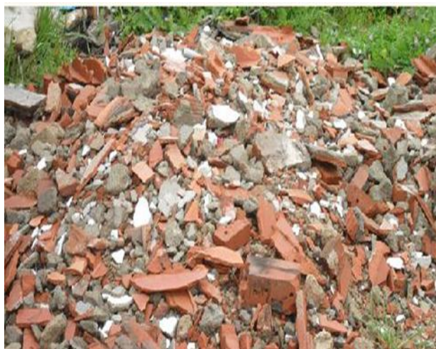
Figura 2 - Resíduos de construção e demolição aglomerados em obra (fonte: Google images)
