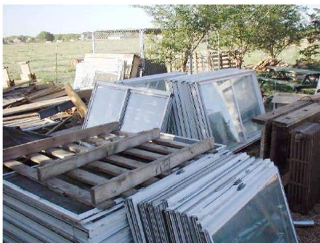
Figura 16 - Triagem em obra de materiais que resultam do processo de demolição (fonte: Deconstruction Institute, 2005)
