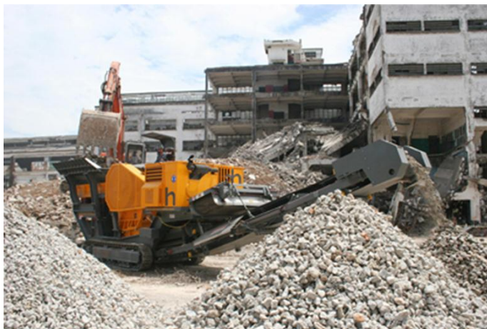
Figura 6 – Equipamento de triagem dos RCD em obra (fonte: Google images)
