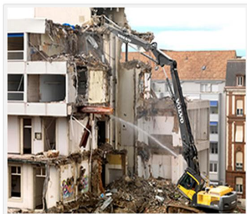
Figura 3 - Resíduos gerados através do processo de demolição (fonte: Google images)
