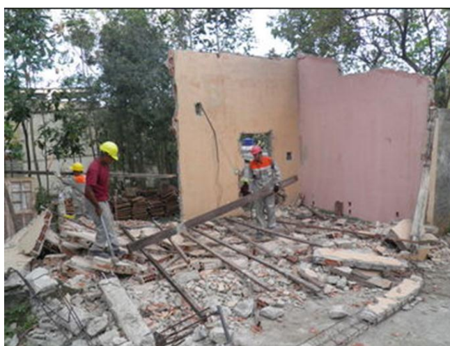
Figura 18 - Demolição seletiva - execução dos trabalhos (fonte: Google images)
