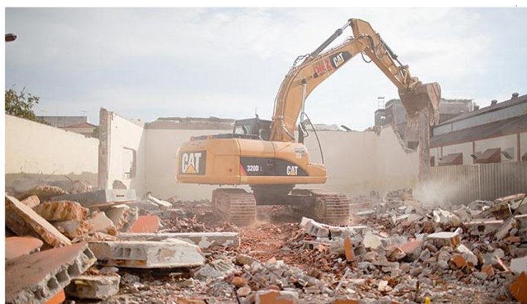
Figura 13 - Exemplo de execução da Demolição Convencional (fonte: Google images)
