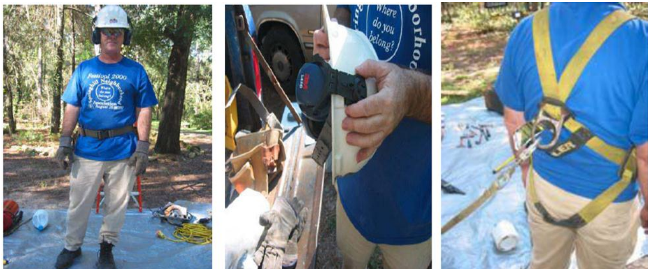
Figura 15 – a) Trabalhador com equipamento (esq.); b) Capacete de proteção (centro); c) Arnês (dir); (fonte: “Guide to Deconstruction”, 2003)
