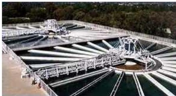
Figura 2.8-Sedimentador quadrado (Valley water)
