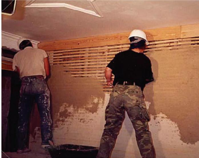
*Figura 9.30: Revestimento do fasciado com argamassa
