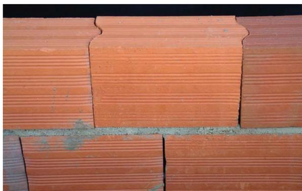
Figura 6.25: Alvenaria Executada com Tecnotijolo® (Neves, 2005)
