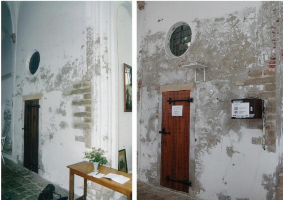
*Figura 9.12: Deterioração de argamassa de reabilitação aplicada entre 1991 e 1995 em edifício antigo na Holanda (Hees et al., 2009)*
