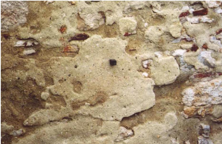
*Figura 9.34: Perda de coesão e erosão em argamassa recente de cal hidratada com gordura (Veiga, 2003)*
