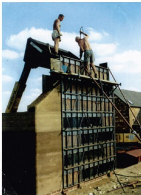
*Figura 8.11: Construção em taipa com cofragens metálicas, Austrália
