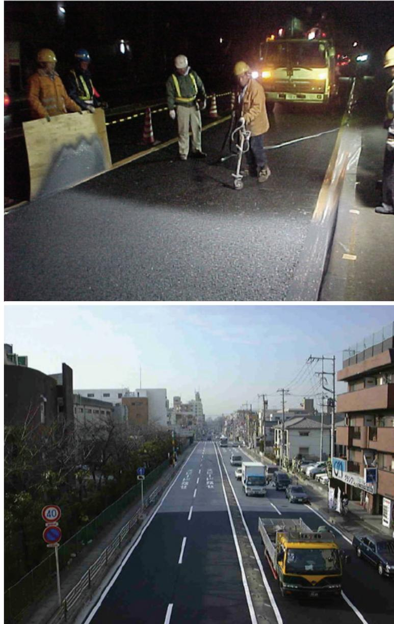
**Figura 10.17:** Utilização de TiO<sub>2</sub> em estrada para conversão do poluente óxido nítrico NO<sub>x</sub>: a) Fase de aplicação; b) visualização de troço de estrada impregnado com a cor mais clara (Fujishima et al., 2008)
