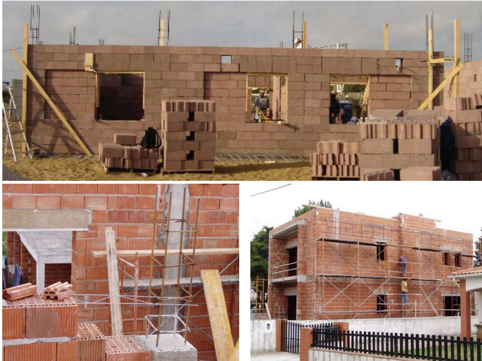
*Figura 6.5: Alvenaria confinada: Em cima conjunto habitacional no Algarve; Em baixo: Execução de Parede com Blocos de Cerâmicos de Furação Vertical e Moradia em Ílhavo (Lourenço, 2007)*
