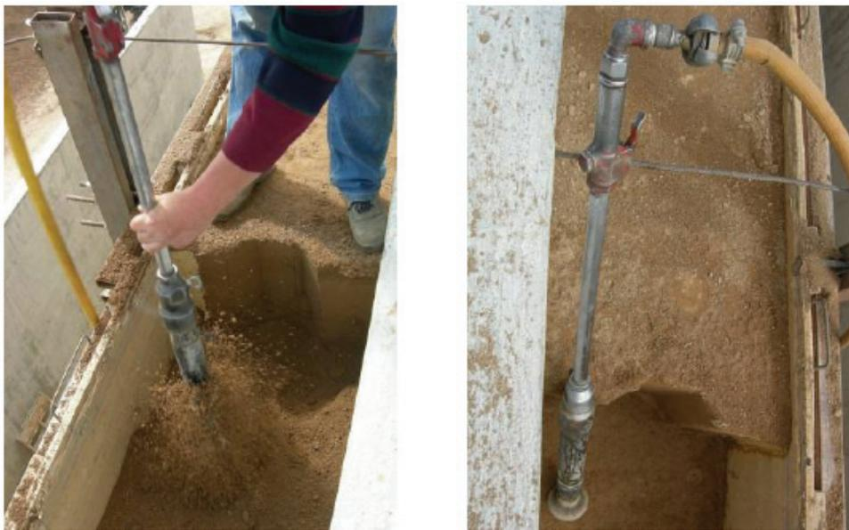
*Figura 8.13: Compactação de terra por meios mecânicos (Foto da firma Betão e Taipa- Construção de adega, Herdade do Rocim)*
