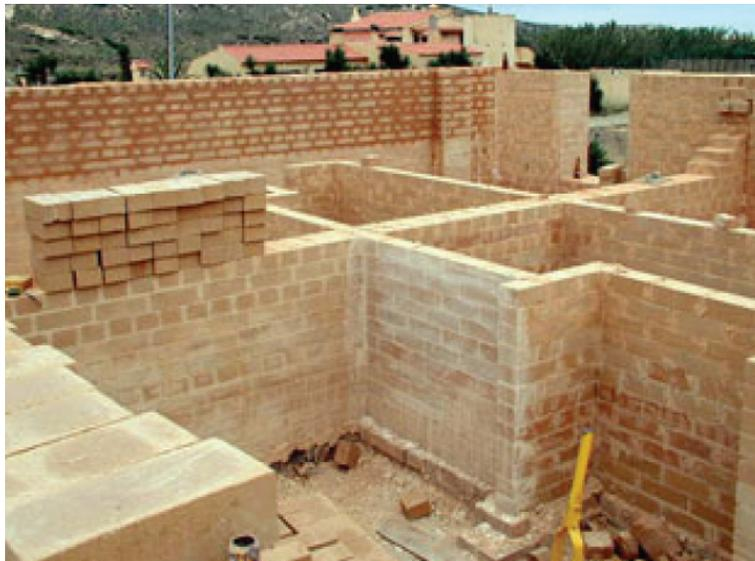
*Figura 8.16: Construção de alvenarias com recurso a BTC, Alentejo*
