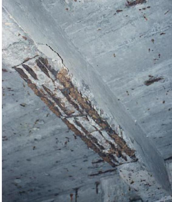
*Figura 9.9: Destacamento da camada de recobrimento em viga de betão devido à formação de produtos de corrosão*
