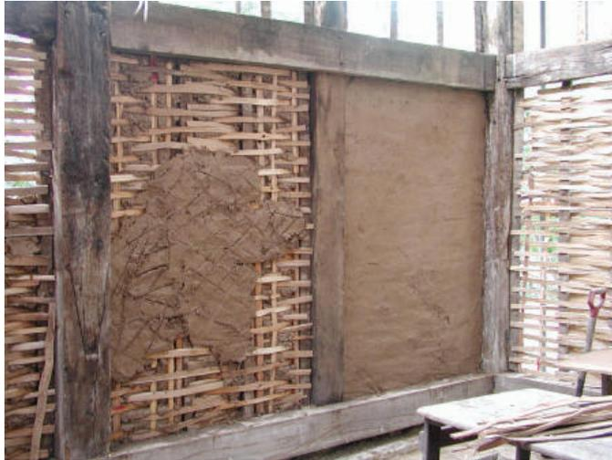
*Figura 8.8: Paredes de terra sobre engradado em madeira*
