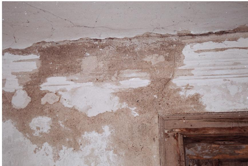
*Figura 9.14: Revestimento de estuque degradado por eflorescências (Torgal & Jalali, 2009)*
