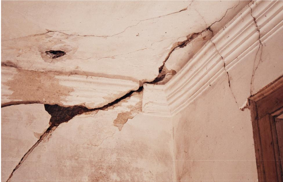
. *Figura 9.15: Revestimento de estuque com fissuras de origem estrutural*
