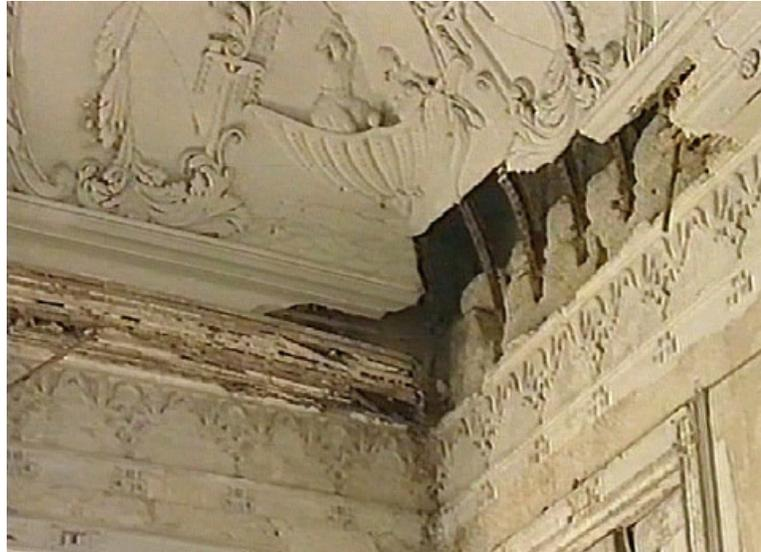
*Figura 9.13: Degradação de revestimentos em estuque devido a deterioração da estrutura da cobertura (Cotrim et al., 2008)*
