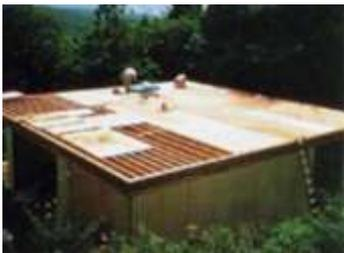
A cobertura tem uma estrutura em madeira revestida em contraplacado.
