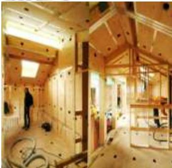
Seguindo o princípio "*design for assembly*", os elementos construtivos podem ser montados logo com os acabamentos necessários. Concluída a montagem e finalizada a cablagem elétrica e hidráulica, cada elemento apresenta-se com um furo para que possa ser insuflado o isolamento no seu interior.
