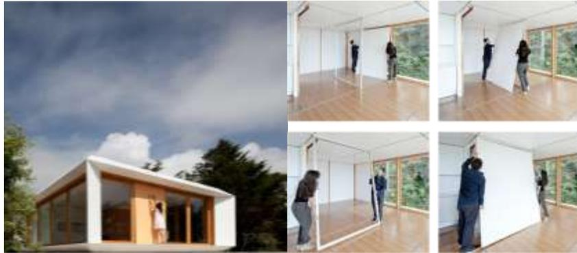
Figura 4.91: MIMA: a) Imagem 3D do projeto; b) Método de desmontagem/montagem de uma divisória (Disponível em: <http://www.mimahousing.pt>).
