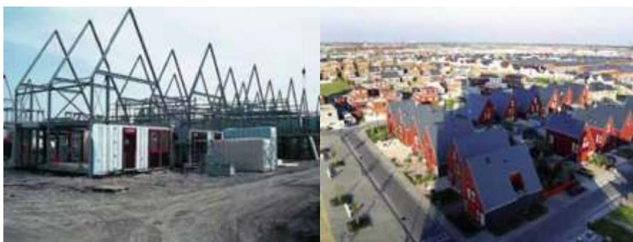
Figura 4.28: Projeto Metal Works Housing: estrutura metálica primária e vista do bairro (TEAGUE, 2005)
