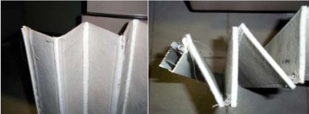
Figura 6.31: FWS: o sistema de fole com o perfil da estrutura, as tiras de poliéster prensado e as fixações costuradas.
