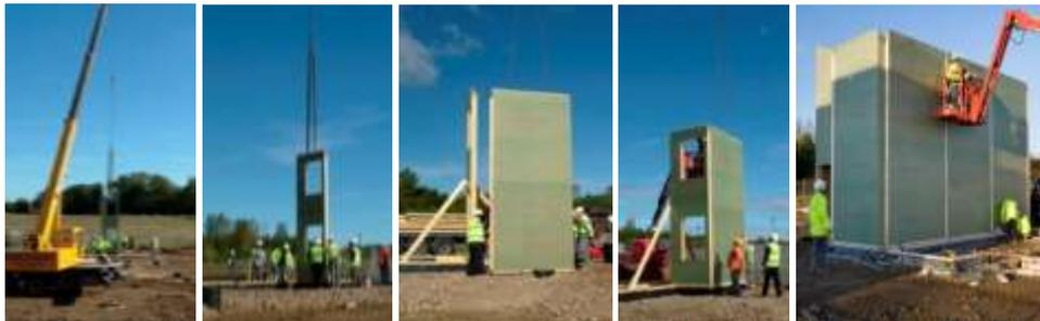
Figura 4.88: Fases de construção-montagem de uma moradia do aldeamento Oxley Park (Disponível em: <http://www.richardrogers.co.uk>).
