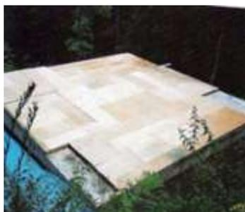
Laje de betão armado revestido com painéis de madeira compensada.
