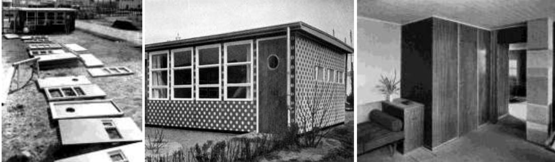
Figura 4.37: Werfthaus: elementos modulares, casa completa, interiores (SCHNEIDER & TILL, 2007).
