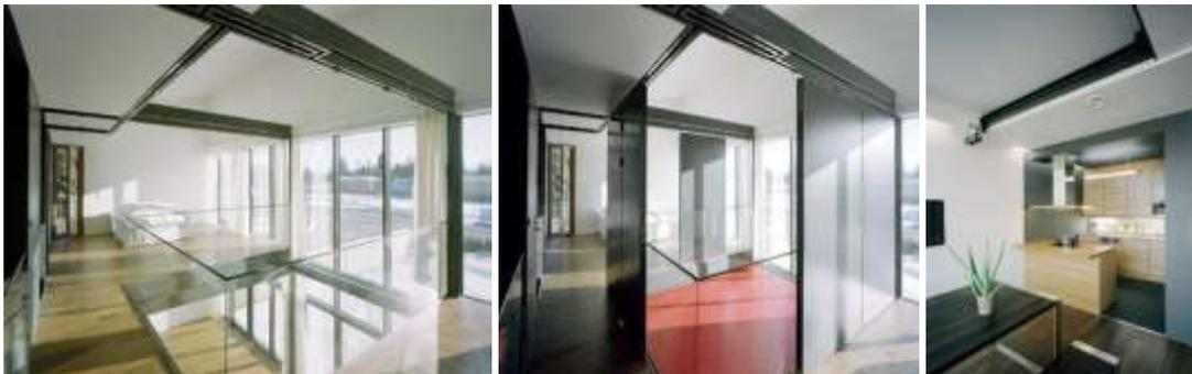
Figura 4.11: Villa Flexible: a) Sistema de divisórias deslizantes e desdobráveis verticais que permitem a compartimentação da área noturna; b) Em vermelho a laje flexível que compartimenta horizontalmente os dois pisos; c) Zona da cozinha com o sistema de fecho horizontal. (Disponível em: <http://www.avan.to/flex/flex.htm>)
