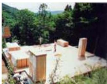
As unidades móveis, pré-montadas, são colocadas nas próprias posições.
