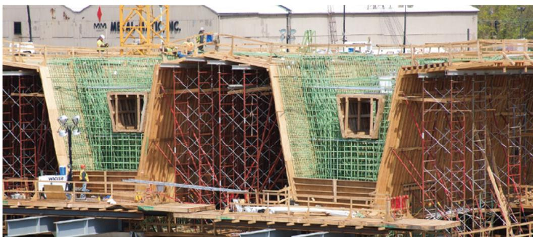
Figura 4.1 – Vista geral de uma ponte com armaduras revestidas com resina epóxida
