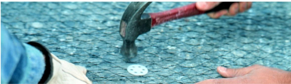
Figura 4.29 – Fixação das malhas de titânio ativado à laje de betão recorrendo a fixadores plásticos (Clemeña e Jackson, 2000)
