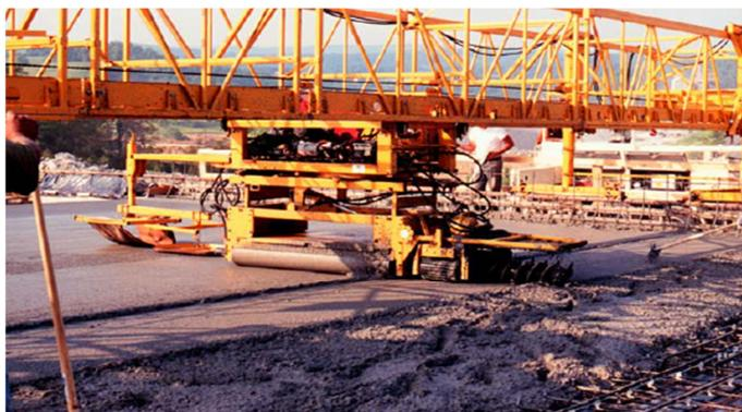
Figura 4.38 – Colocação do betão sobre as armaduras e sistema de proteção catódica (Clemeña *et al.*, 2003)
