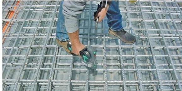
Figura 4.7 – Amarração de armaduras galvanizadas
