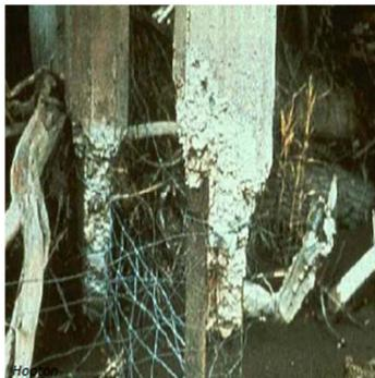
Figura 3.17 – Deterioração do betão devido ao ataque dos sulfatos
