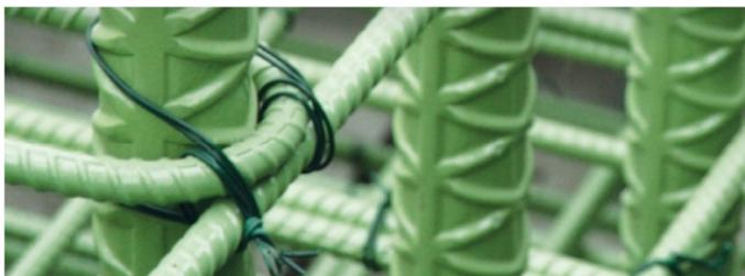
Figura 4.3 – Pormenor de amarração de armadura protegidas com revestimento epóxido
