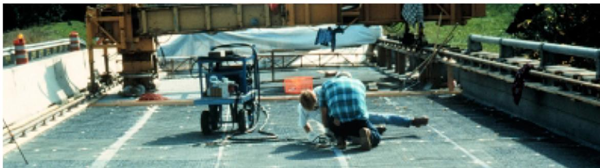
Figura 4.27 – Operação de colocação da malha de titânio ativado num tabuleiro (Clemeña e Jackson, 2000)
