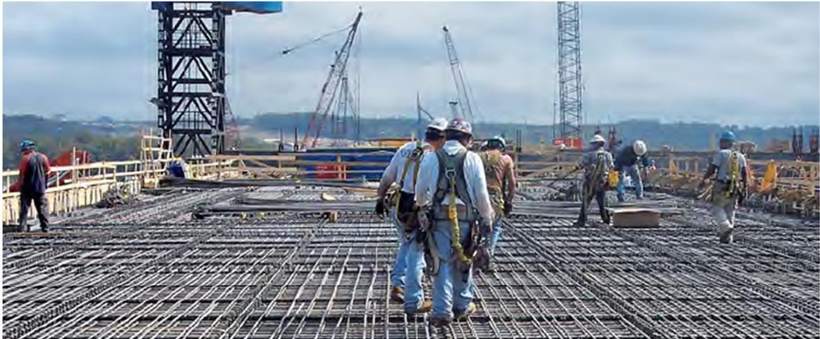
Figura 4.11 – Aplicação de armaduras de aço inoxidável num tabuleiro de uma ponte (IMOA, 2009)
