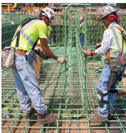
Figura 4.2 – Processo de amarração das armaduras protegidas com revestimento epóxico
