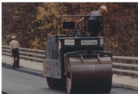
Figura 4.24 – Aplicação do revestimento condutor
