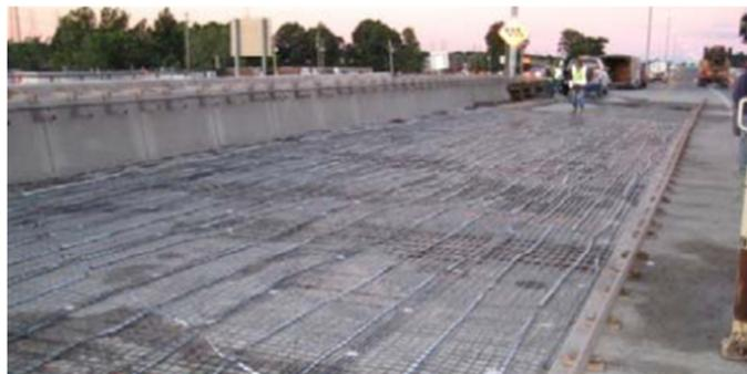
Figura 4.37 – Colocação do ânodo distribuído em laje (Ball e Whitmore, 2009)
