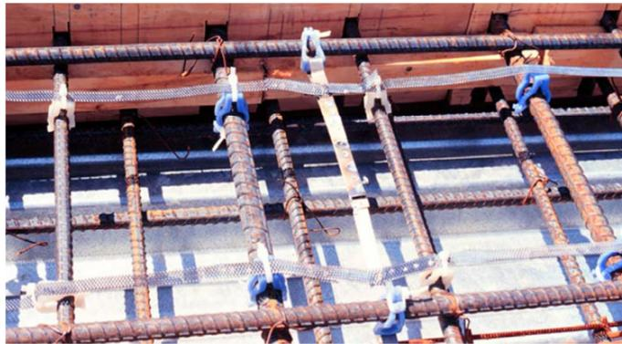
Figura 4.36 – Pormenor de um sistema de proteção catódica por corrente impressa (Clemeña *et al.*, 2003)
