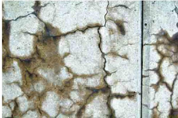
Figura 3.15 – Fendilhação devida às reações álcalis-agregado (FHWA, 2006a)
