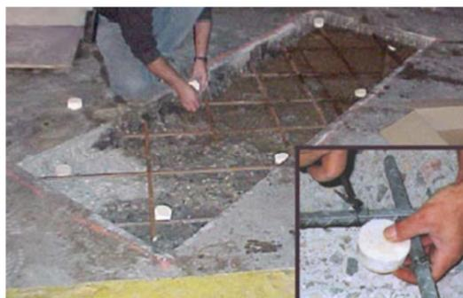
Figura 4.33 – Colocação de ânodos sacrificiais em reparação localizada (Ball e Whitmore, 2009)
