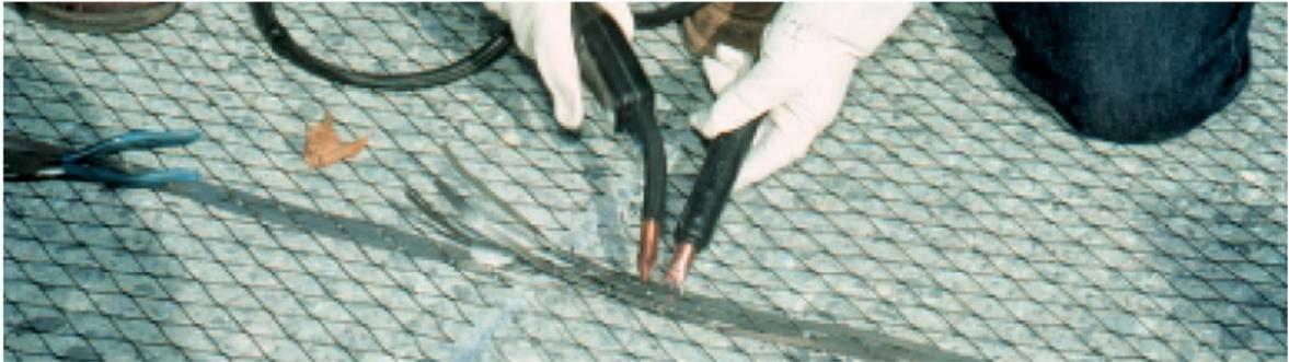
Figura 4.28 – Ligação de duas malhas recorrendo à soldadura de uma tira de titânio ativado (Clemeña e Jackson, 2000)
