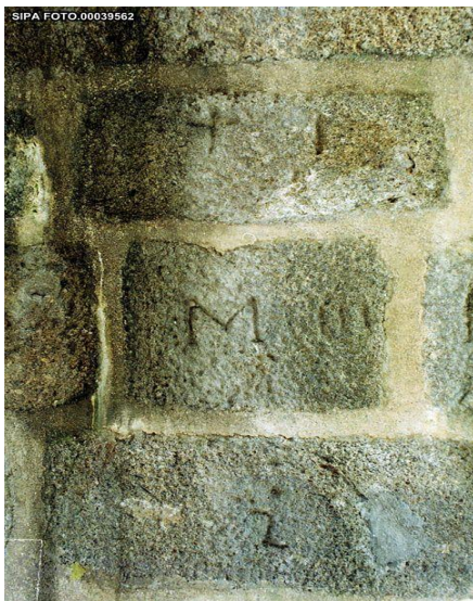
Figura 4- Exemplos de siglas existentes nos contrafortes da ponte (imagem: www.monumentos.pt ).
