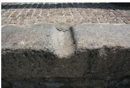
Figura 15- Pormenor de canalização reaproveitada.
