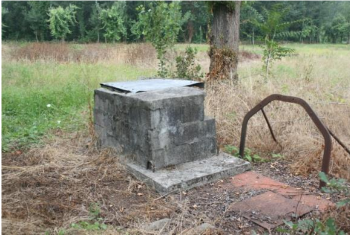
Figura 76- Poço junto ao E.C.24.
