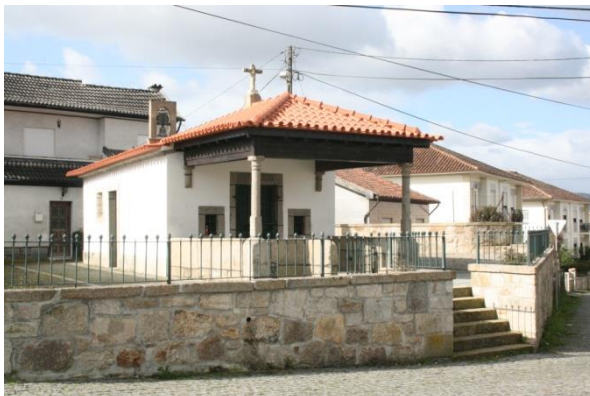
Figura 5- Capela de S. Roque, vista geral.
