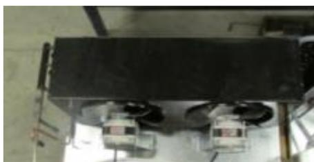
Figura 30 - Condensador de duas golas com os ventiladores montados
