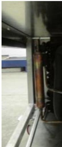
Figura 37 - Filtro secador
