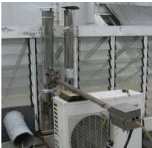
Figura 3.12: Analisador de gases, fixo na chaminé
