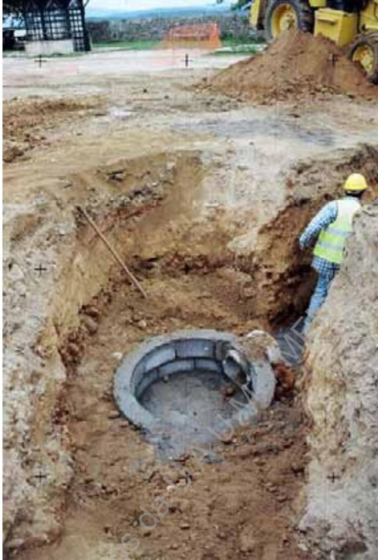
**Foto 168 (A326)** – Rua Major Severino, pormenor da construção de uma caixa de visita no final do ramal das canalizações para as águas pluviais.
