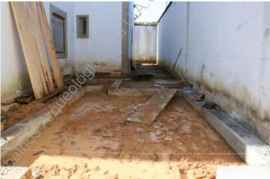
Foto 257 (D4808) – Paiol de Marte, betonagem das sapatas, reforço do alicerce.
