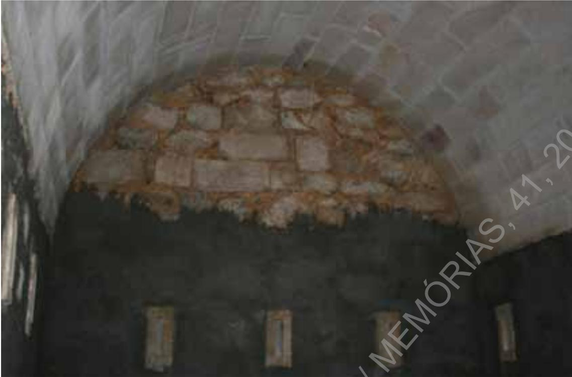
**Foto 245 (D4909)** – Paiol de Marte, pormenor da betonagem das paredes interiores.
