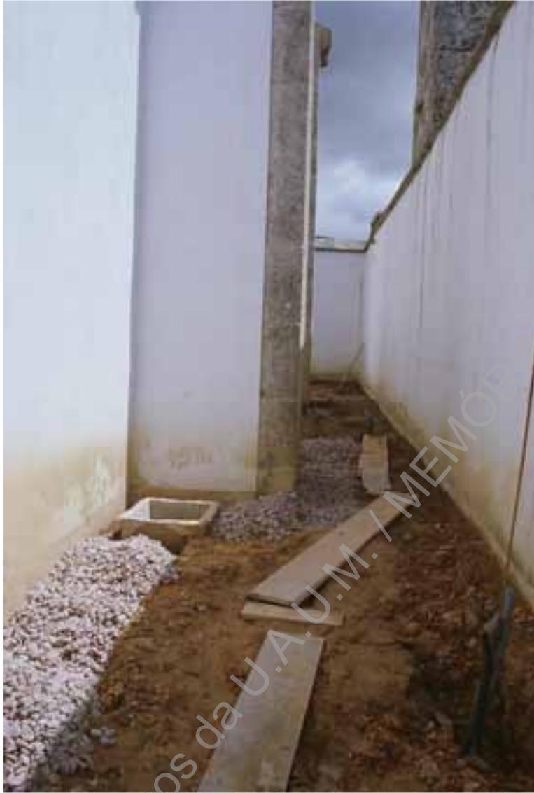
**Foto 253 (A5757)** – Paiol de Marte, enchimento da vala de águas pluviais.
