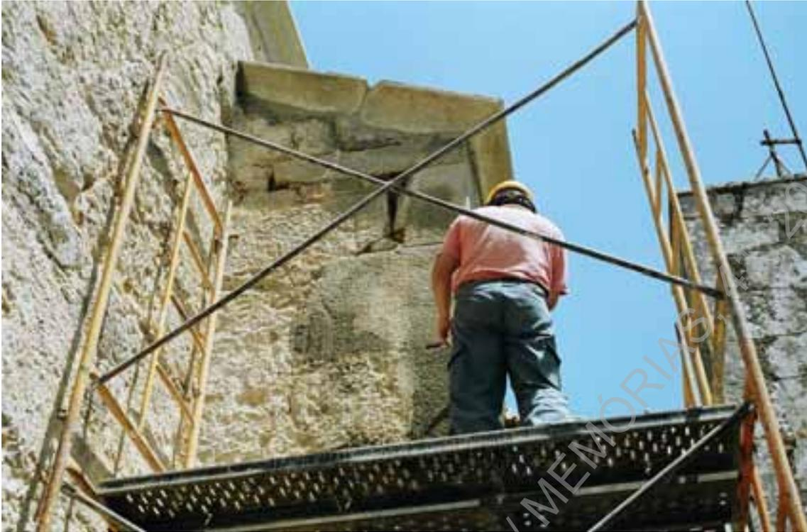
Foto 235 (A2183) – Paiol de Marte, picagem das paredes exteriores do paiol.
