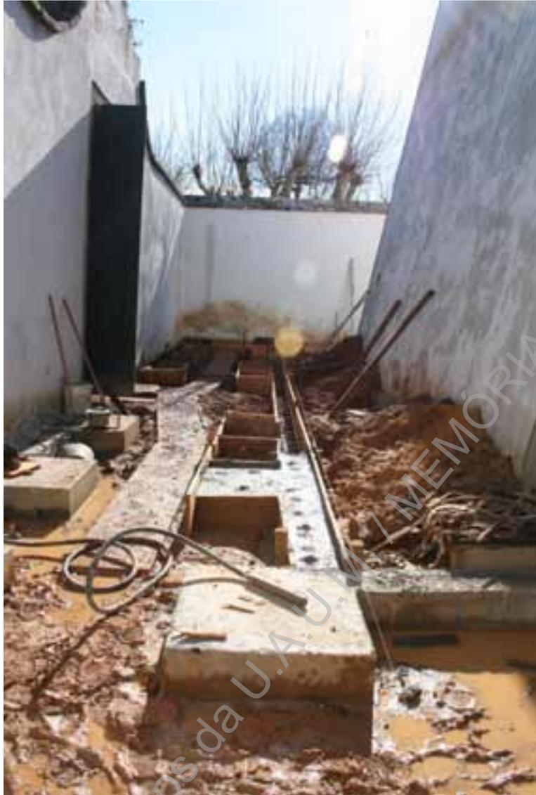
Foto 258 (D4809) – Paiol de Marte, betonagem das sapatas, reforço do alicerce.
