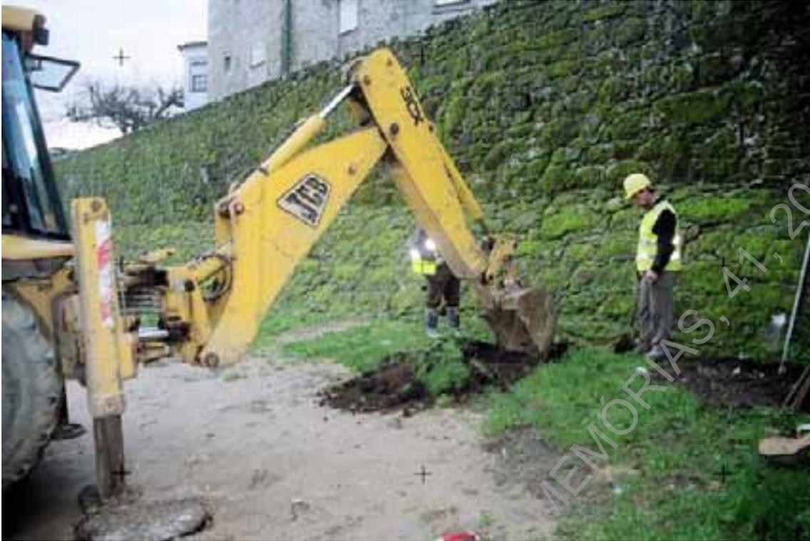
Foto 224 (A679) – Acesso à Coroada, pormenor da abertura da sondagem junto à muralha.
