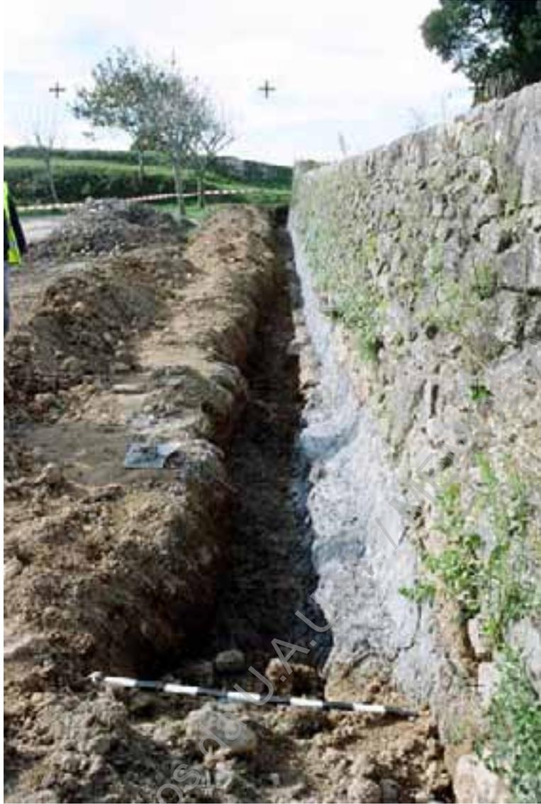
**Foto 203 (A424)** – Campo de Marte, pormenor da colocação de cimento no fundo da vala para drenagem.
