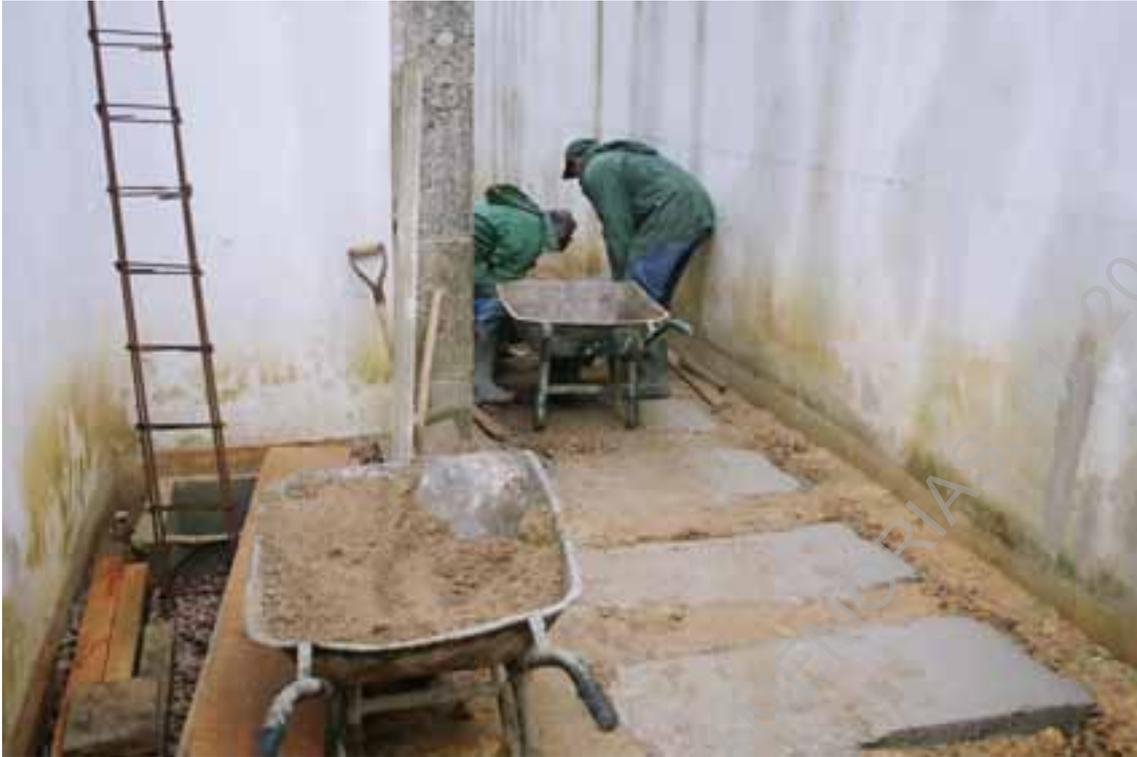
Foto 262 (A5963) – Paiol de Marte, colocação do lajeado no corredor exterior.
