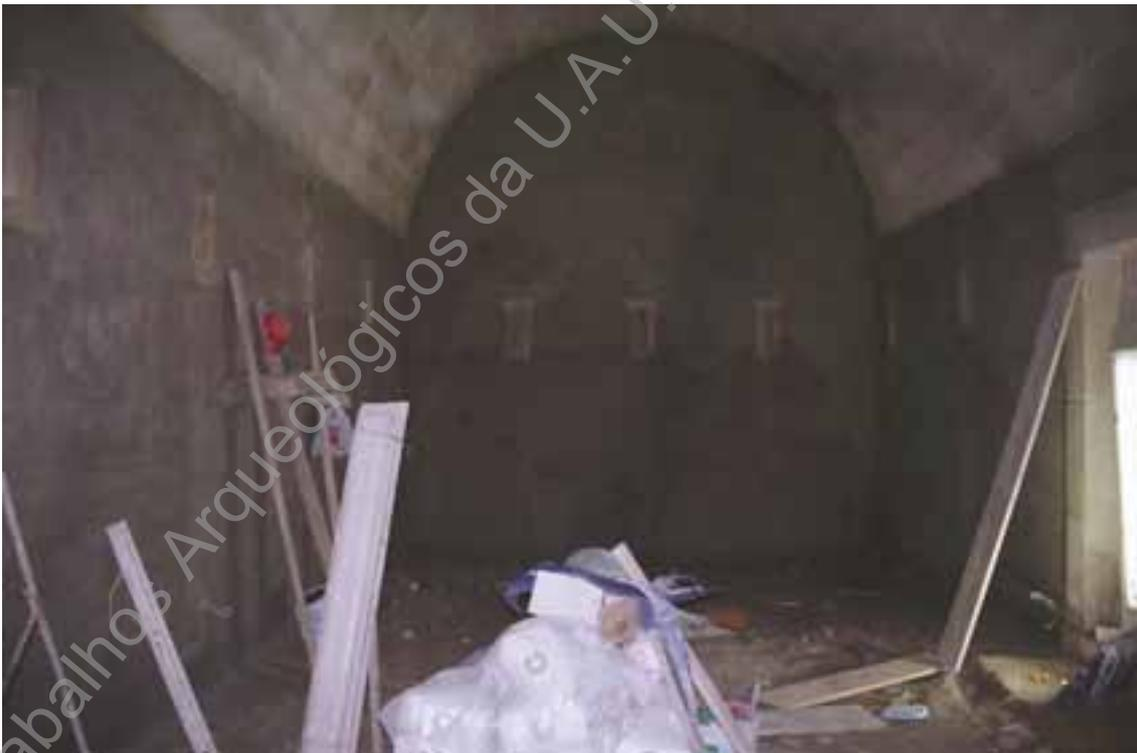
**Foto 246 (A5846)** – Paiol de Marte, aspeto geral da betonagem das paredes interiores.
