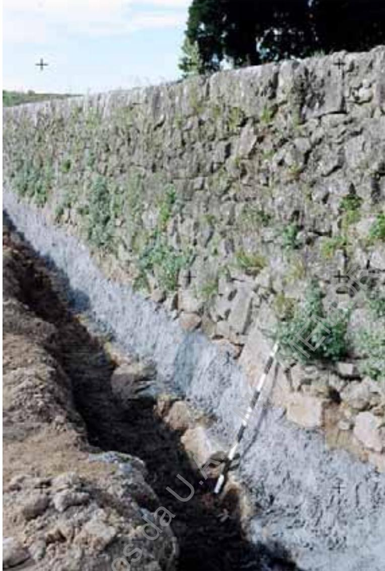
**Foto 202 (A423)**– Campo de Marte, pormenor da colocação de cimento no fundo da vala para drenagem.
