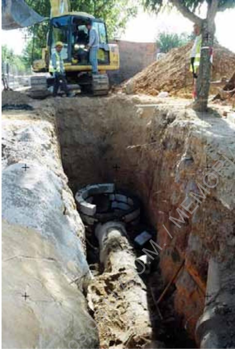
**Foto 165 (A316)** – Rua Major Severino, pormenor da construção de uma caixa de visita das canalizações para as águas pluviais.
