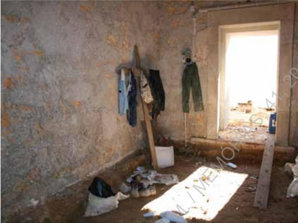
Foto 239 (D4812) – Paiol de Marte, aspeto geral das paredes interiores pós picagem.
