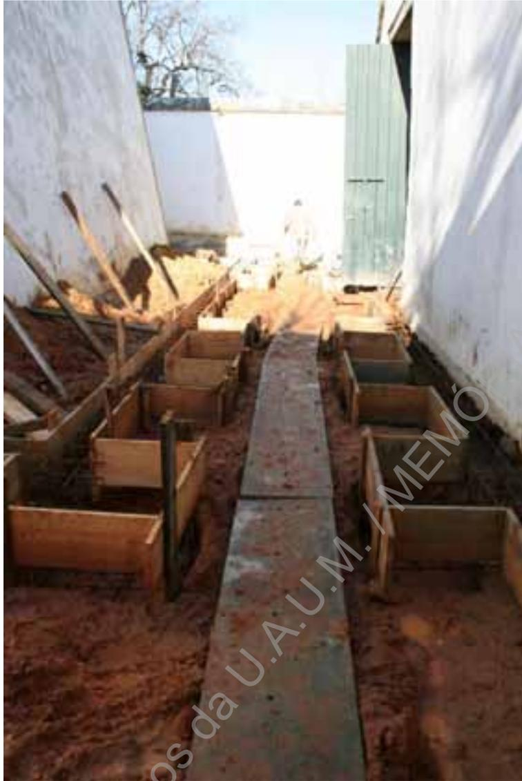
Foto 255 (D4806) – Paiol de Marte, vala para construção de sapatas, reforço do alicerce.
