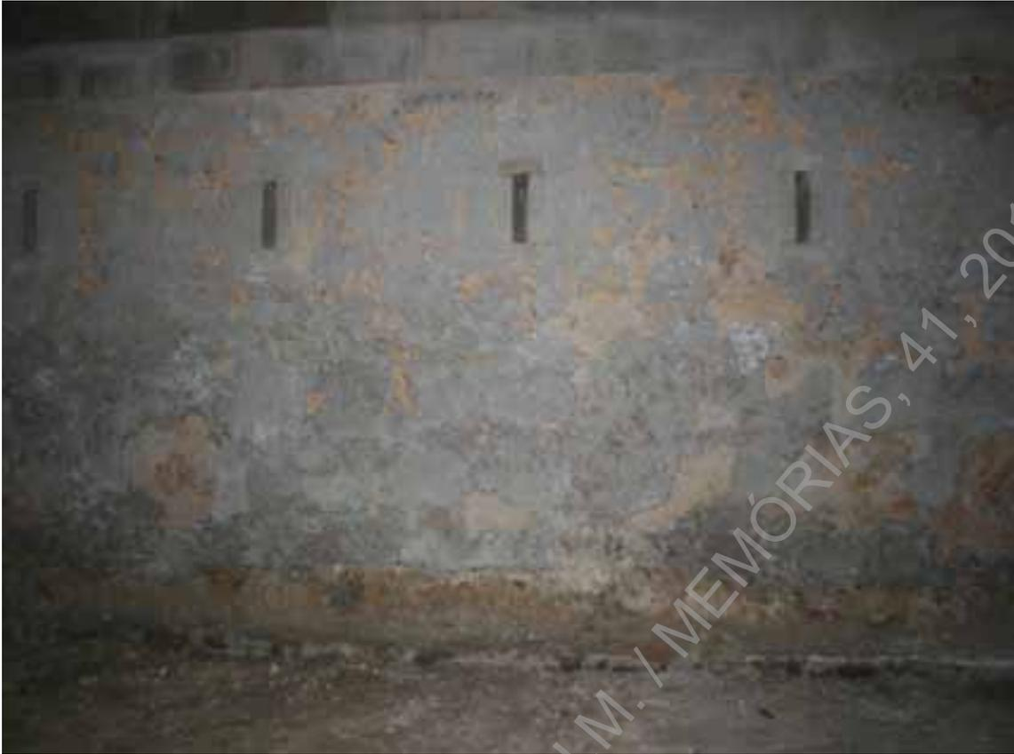
**Foto 241 (D4833)** – Paiol de Marte, aspeto geral das paredes interiores pós picagem.
