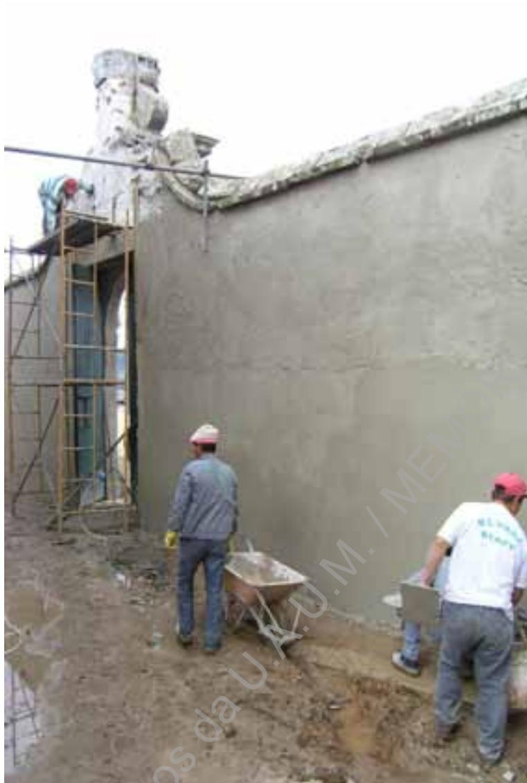
**Foto 248 (D2069)** – Paiol de Marte, aspeto geral da betonagem das paredes exteriores.
