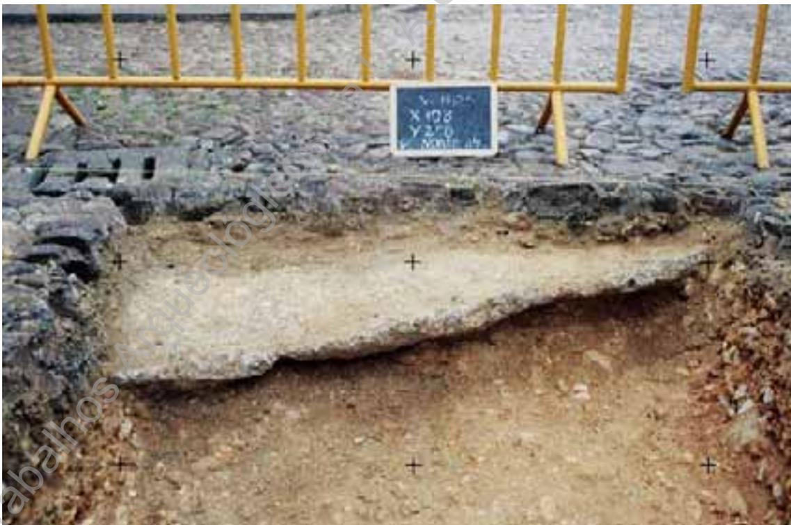
Foto 51 (A179) – Sondagem X193 Y250, pormenor da cobertura de cimento (0143) para os cabos de eletricidade.
