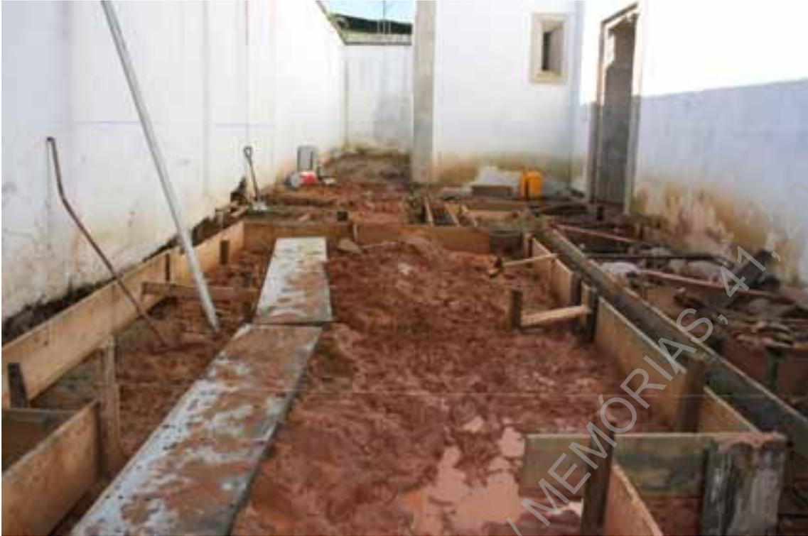
Foto 256 (D4807) – Paiol de Marte, vala para construção de sapatas, reforço do alicerce.
