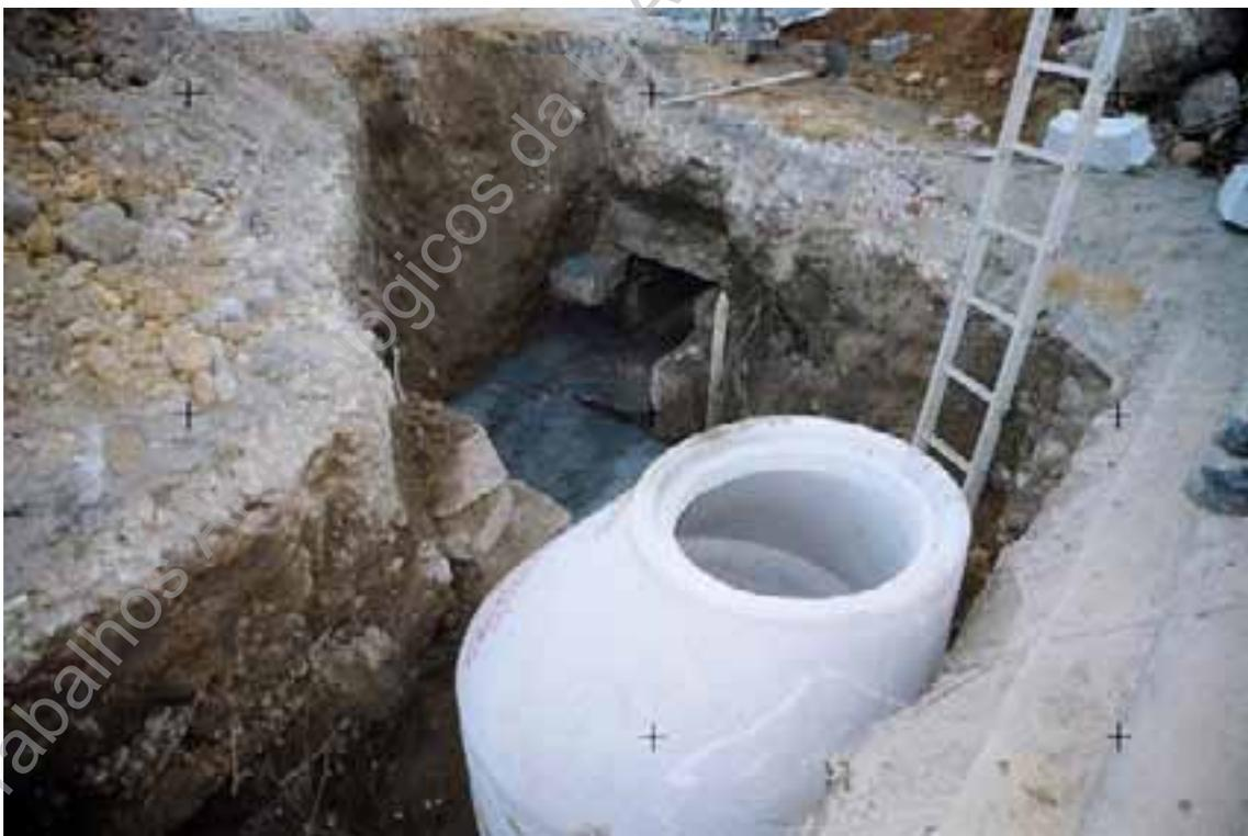
**Foto 220 (A490)** – Avenida de Cristêlo, pormenor conduta (0230), depois da instalação da caixa de visita.
