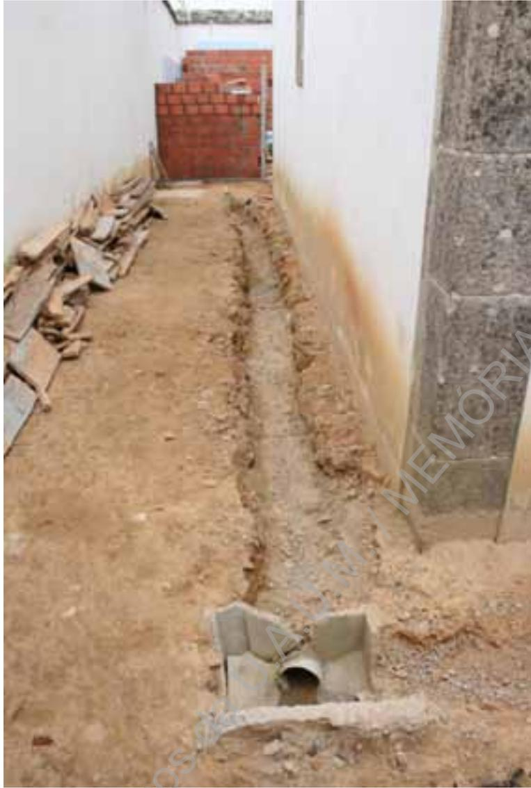
**Foto 251 (D4860)** – Paiol de Marte, vala para águas pluviais.
