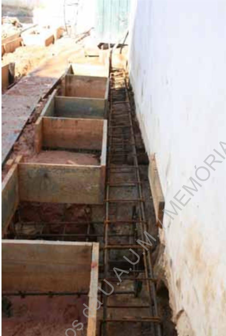
**Foto 254 (D4805)** – Paio de Marte, vala para construção de sapatas, reforço do alicerce.
