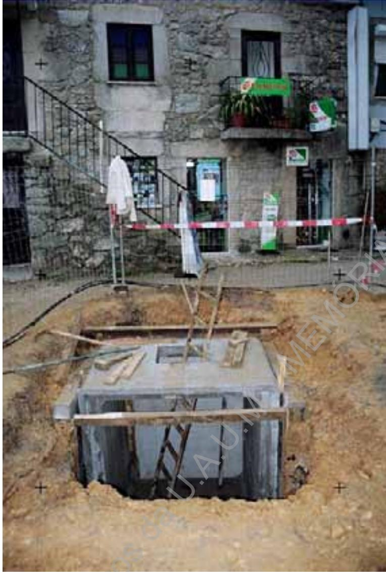
Foto 186 (A602) – Travessa do Cantinho, pormenor da implantação de uma *box* da galeria técnica.
