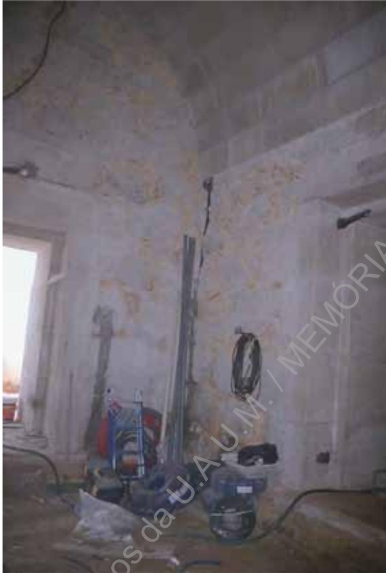
Foto 243 (A5768) – Paiol de Marte, aspeto geral das paredes interiores pós picagem.
