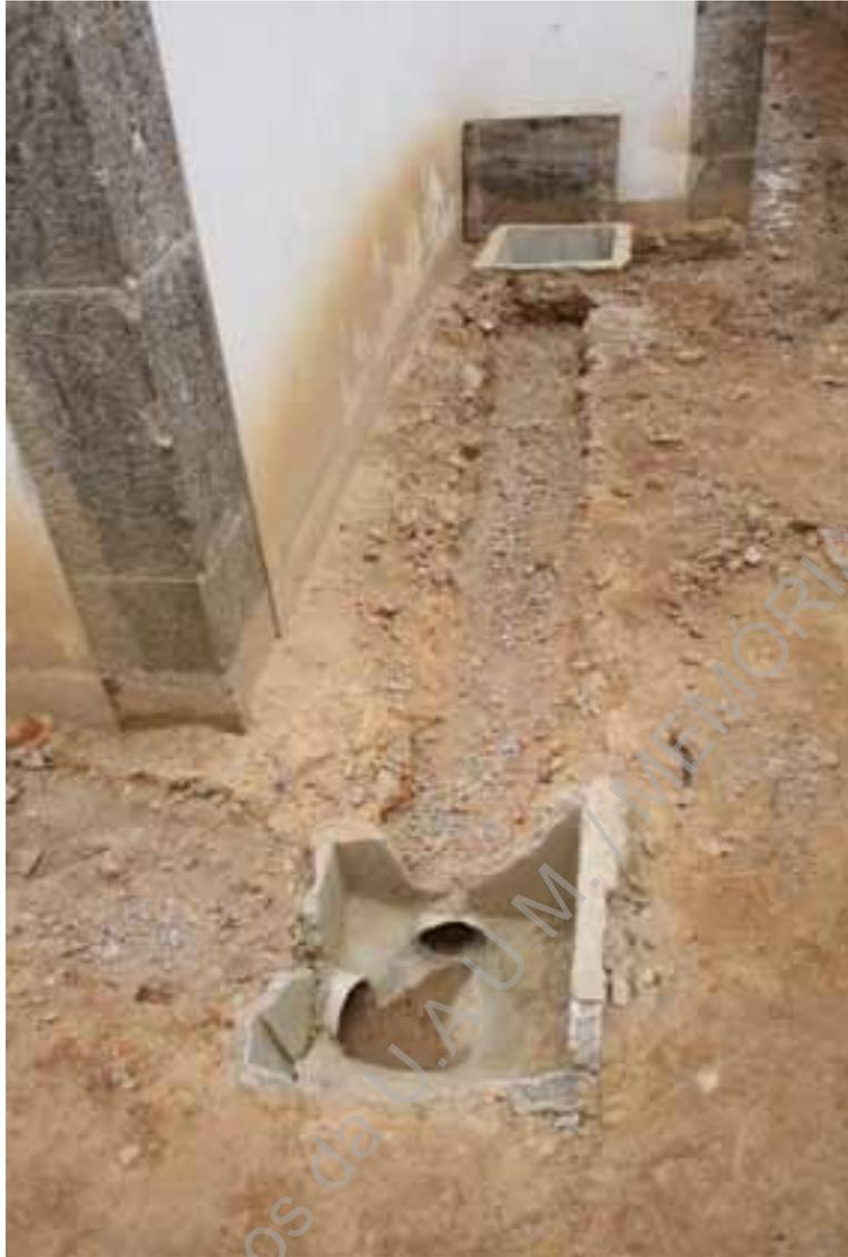
Foto 252 (D4861) – Paiol de Marte, vala para águas pluviais.
