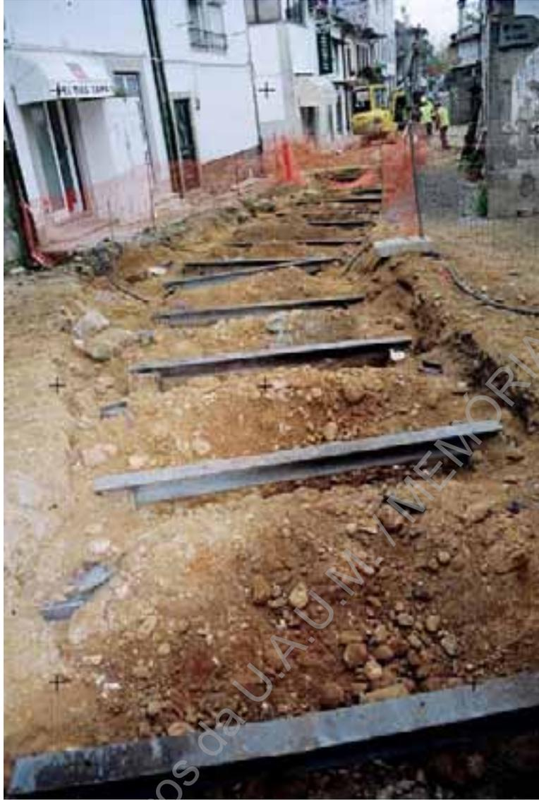
**Foto 187 (A583)** – Travessa do Cantinho, pormenor da zona após a implantação da galeria técnica.
