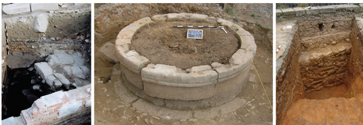
Figura 2 – Da esquerda para a direita: Pormenor de ruínas modernas e contemporâneas no Baluarte de Santo António; Pormenor do poço do Campo de Marte; Pormenor da solução construtiva da cortina setentrional da Coroada.
