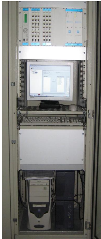
Figura 32 – Fotografia do sistema de monitorização de vibrações (rack e computador)
