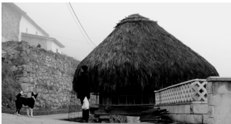
Fig. 2. Hórreo em Somiedo, Astúrias, com telhado de palha e estrutura em madeira ( http://imaginacaoativa.wordpress.com/tag/asturias/ )
