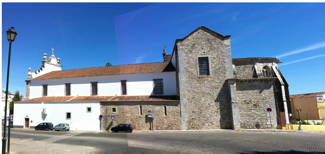
Fotografia da fachada lateral do Convento de S. Domingos em Elvas.
