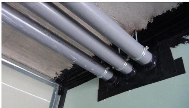
**Figura 61** – Aplicação de banda betuminosa flexível na ligação da tubagem de ventilação com a parede (Fonte: Homegrid, 2012)
