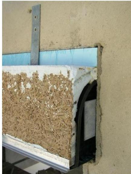
**Figura 58** – Vista da execução das caixas de estore (Fonte: Homegrid, 2012)
