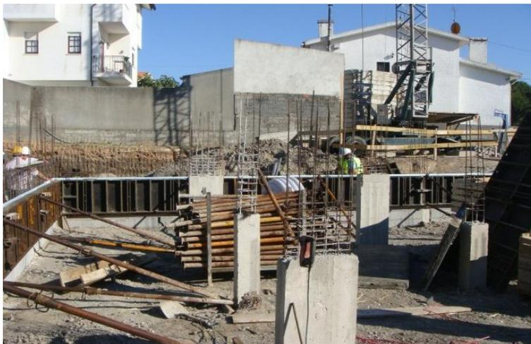
**Figura 45** – Vista da execução das fundações (Fonte: Homegrid, 2012)
