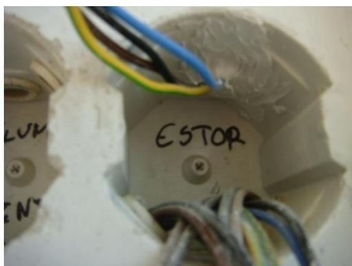
**Figura 62** – Aplicação de vedantes à base de poliuretano nas caixas das tomadas (Fonte: Homegrid, 2012)
