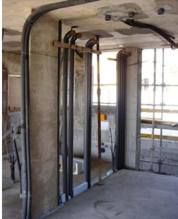
**Figura 60** – Vista da execução das tubagens do sistema de ventilação (Fonte: Homegrid, 2012)
