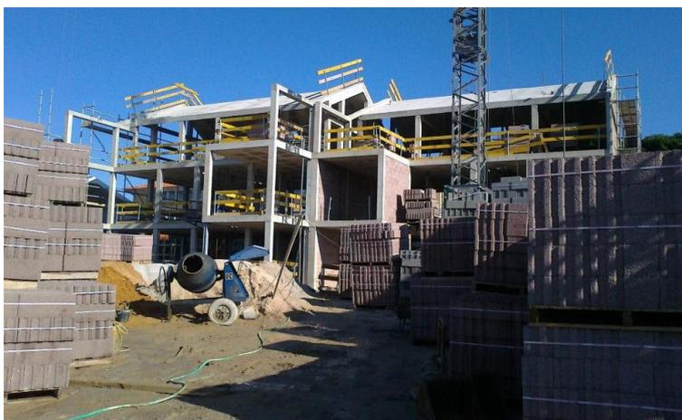
**Figura 47** – Vistas da execução das alvenarias (Fonte: Homegrid, 2012)
