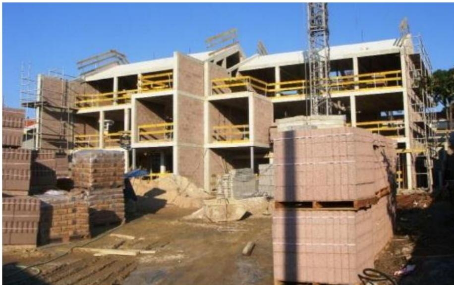
**Figura 54** – Vista da execução das alvenarias exteriores (Fonte: Homegrid, 2012)
