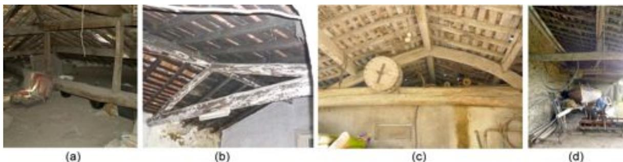
Fig. 4.15 (a) Cobertura de Casa Arruada Urbana com quatro águas (NE7); (b) Cobertura de Casa Elementar de Telheiro com três águas (TL4); (c) Cobertura de telheiro com duas águas (TH2); (d) Cobertura de telheiro com uma água (VL2)
