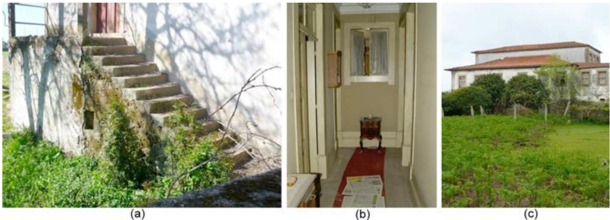
Fig. 4.17 (a) Escada exterior encastrada e apoiada em muretes de xisto (PR2); (b) Divisórias interiores em tabique simples (NE7); (c) Piso recuado com empenas em tabique reforçado revestido a chapa (TR6)
