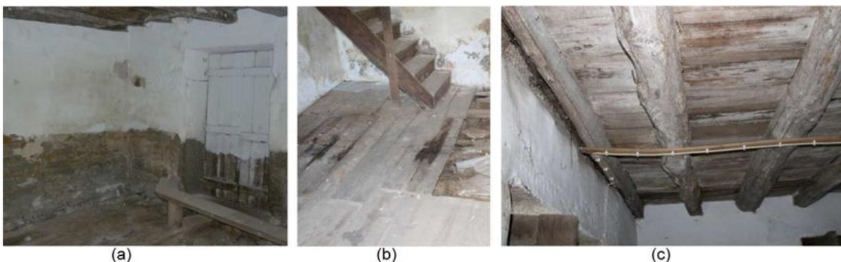
Fig. 6.7 *Loja poente* (a) Porta emparedada na meeira; (b) Escada interior em madeira; (c) Sobrado do volume primitivo
