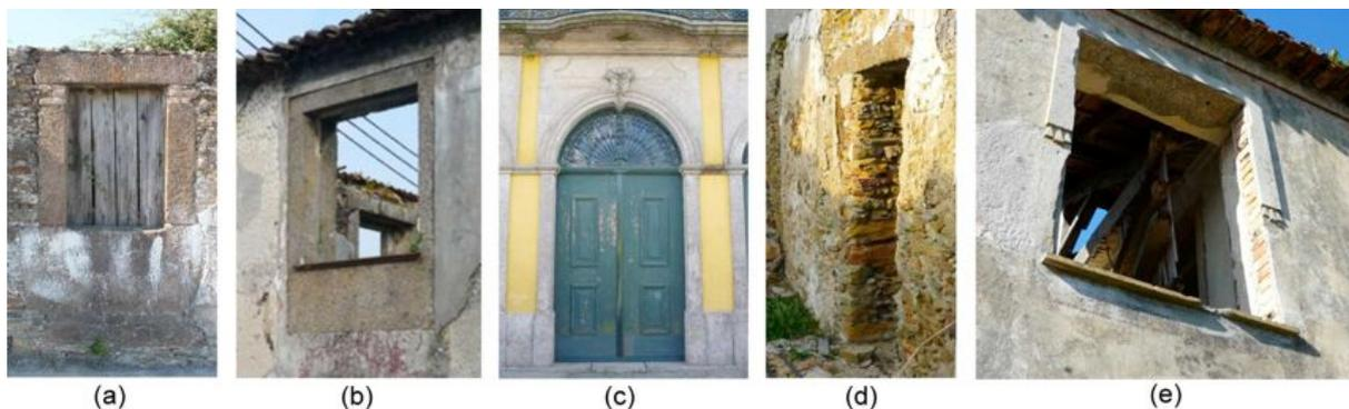
Fig. 4.8 (a) Vão reforçado com cantaria de xisto e travada com tijolo maciço (NE4); (b) Vão reforçado em cantaria simples de granito (NE3); (c) Portal e sacada em cantaria trabalhada de granito (TR4); (d) Vão reforçado com alvenaria de xisto aparelhada (TL2); (e) Vão reforçado com alvenaria de tijolo com moldura em reboco (TH1)
