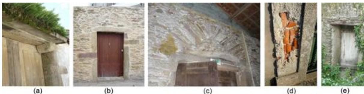
Fig. 4.9 (a) Vão reforçado com padieira dupla em cantaria de granito (IG3); (b) Vão reforçado com cantarias e arco de alívio de volta perfeita em xisto (TR); (c) Vão reforçado por cantaria em xisto com arco de alívio em trapézio de xisto (TR8); (e) Vão reforçado por cantaria de granito serrado industrialmente e com falsa cantaria em reboco armado com fragmentos de telha (CR); (e) Vão reforçado com *pau rolado* e cantaria de granito (NE3)
