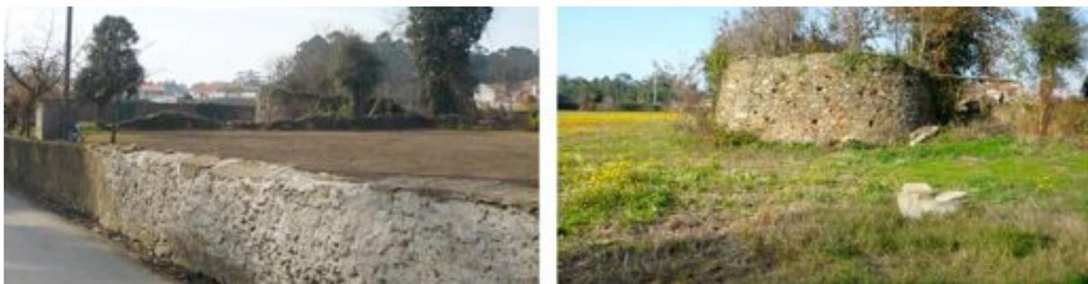
Fig. A 2.38 Imagens do Reservatório LN15 em alvenaria de xisto, que armazenava na sua cisterna água recolhida da Lagoa Negra e que, através de um engenho de tração animal colocado no seu topo, alimentava um muro caleira.
