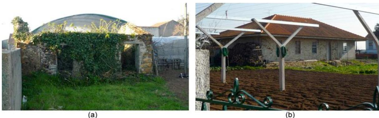
Fig. 5.1 (a) Casa elementar básica em ruína, em o seu anexo agrícola foi demolido (CR6); (b) Casa elementar composta com nova cobertura em betão (CR7); (CR – localizada no Lugar de Criás)
