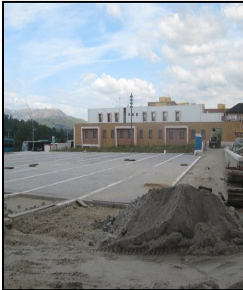
Fig.18: Praça Fernão de Magalhães, Ponte da Barca (ainda em fase de conclusão).
