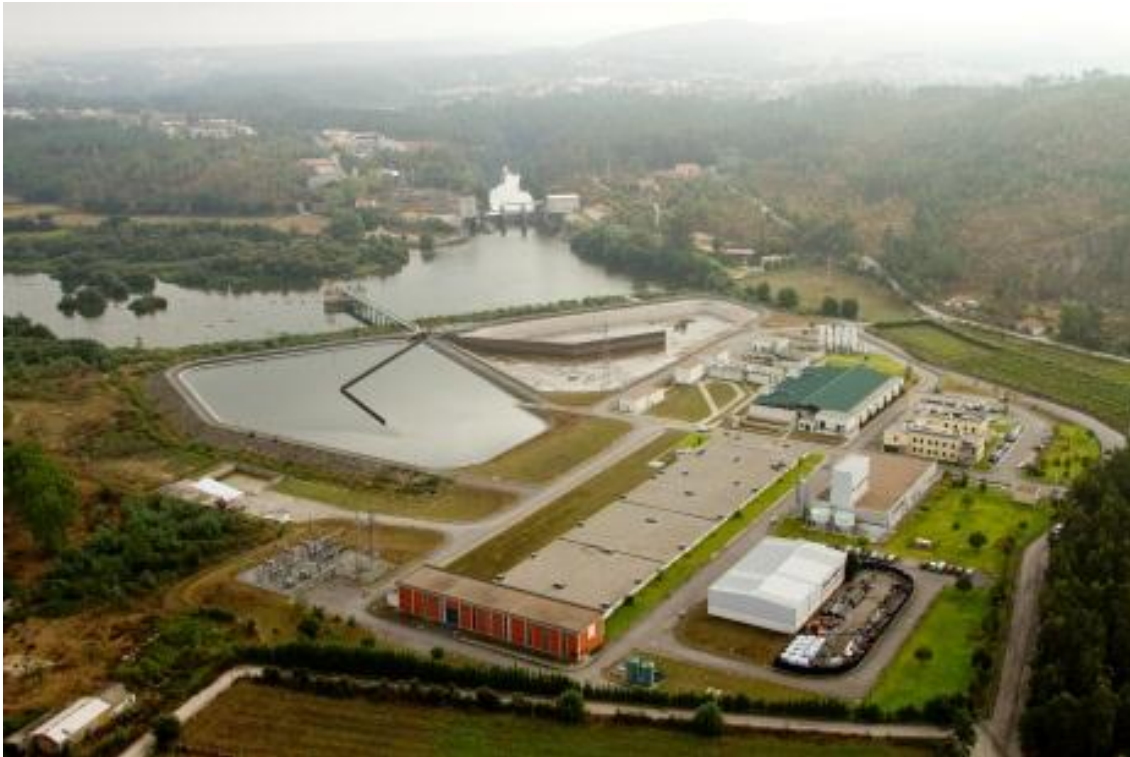
Figura 5: Vista geral da Estação de Tratamento de Água de Areias de Vilar (AdNw, 2010)
