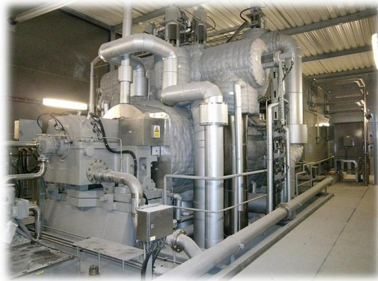
**Figura 170** – Turbina de Contrapressão
