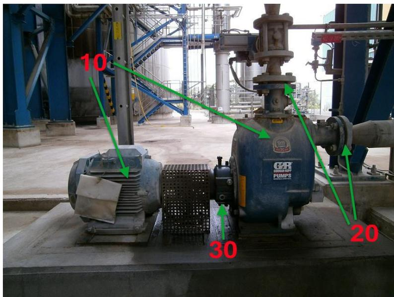
**Figura 43** – Localização dos pontos de inspeção do PT-15-3GB -0071
