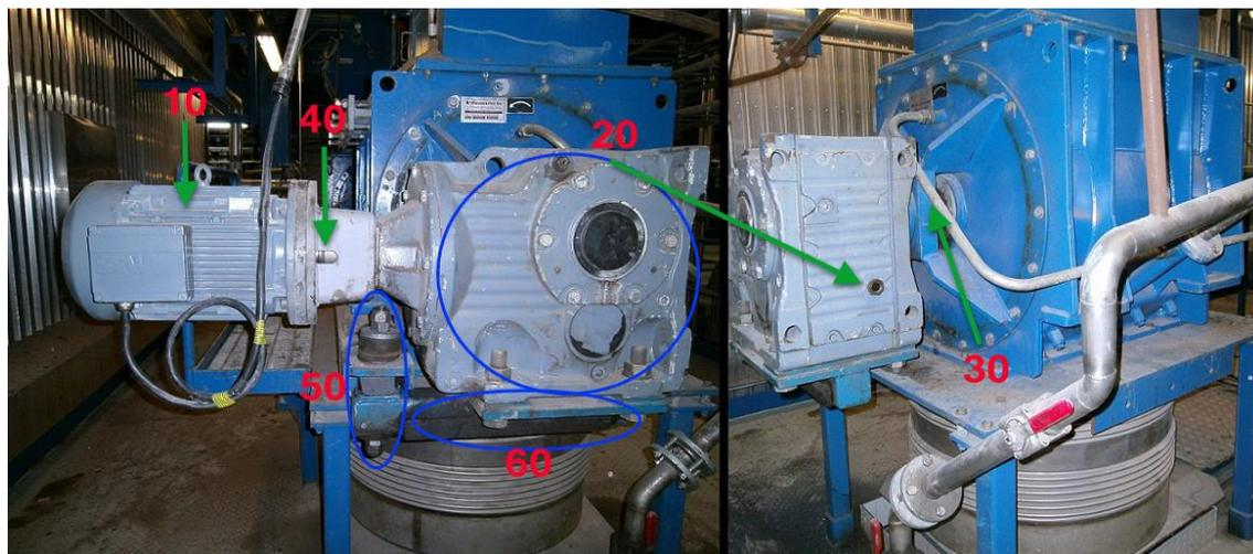
**Figura 66** – Localização dos pontos de inspeção do PT-15-3GAR-0015
