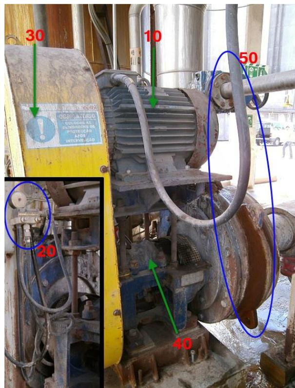
**Figura 81** – Localização dos pontos de inspeção do PT-15-3GB-0073
