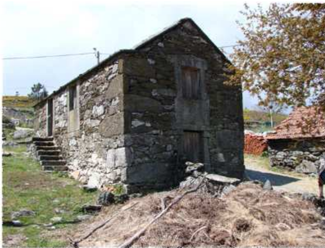
Figura 19. Futuras instalações do CIAPP, antes do início das obras.
