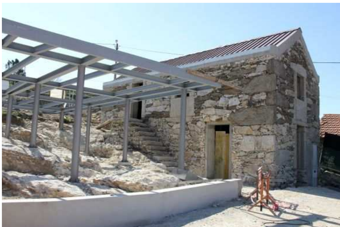
Figura 20. Futuras instalações do CIAPP, depois do início das obras.
