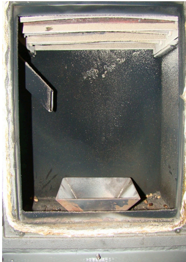
Figura 3.5 - Câmara de combustão da caldeira utilizada na instalação.
