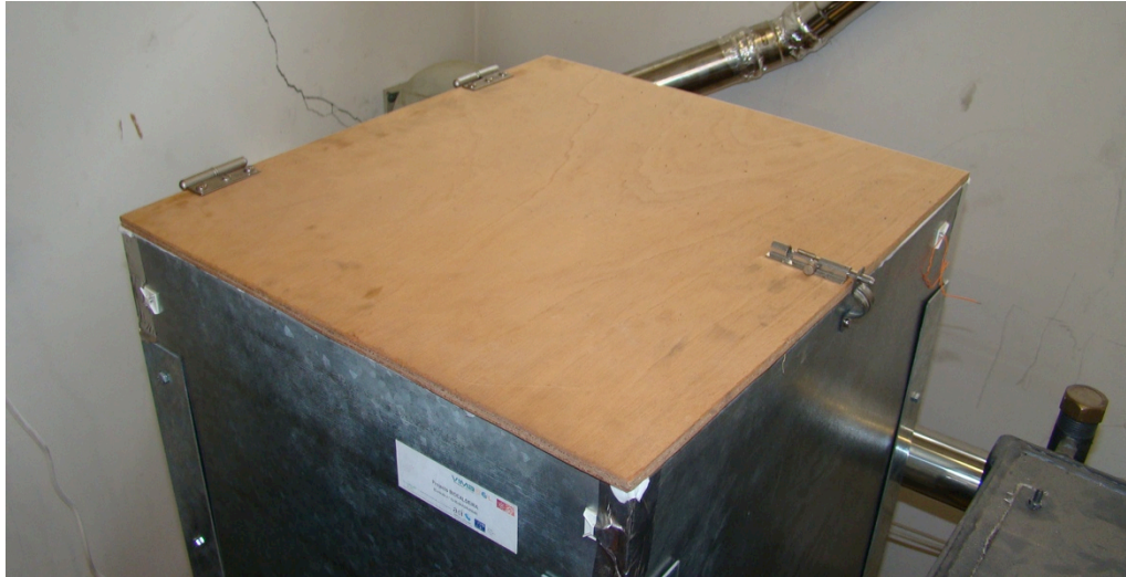
Figura 3.18 - Tampo de vedação do reservatório de pellets
