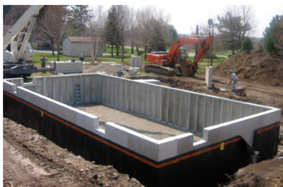
Figura 5.3 - Fundações em betão (fonte: http://precast.org )
