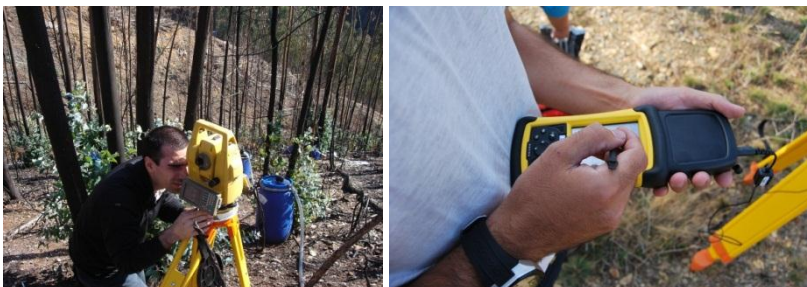
Fotografias 1 e 2. Levantamento topográfico de pormenor efectuado nas áreas de estudo.
