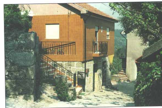
43. A antiga casa do tamanheiro reconstruída pela família que trabalha na Área Metropolitana do Porto. Cimo de Vila (Fig. 36). Orientação (SE/NW); Março 1997.
