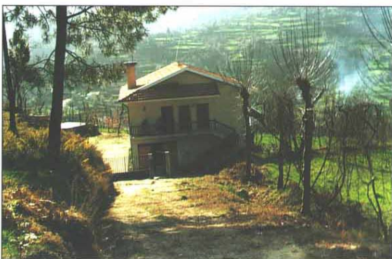
45. Construção da década noventa (casa de um emigrante). Lugar dos Campos (Fig. 36). Orientação (ENE/WSW); Março 1997.
