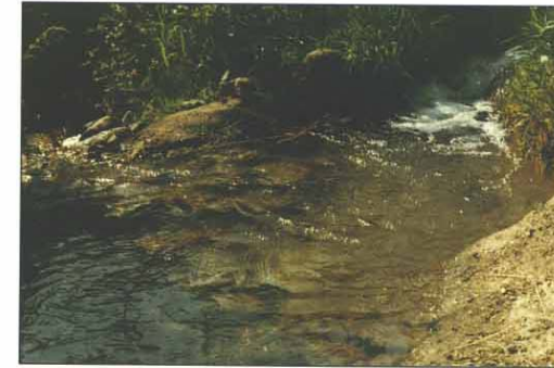
21. Um talhadouro aberto na Levada "desviando" a água cerca de 90° no Margeal (Fig. 36). Orientação (E-W); Março 1997.
