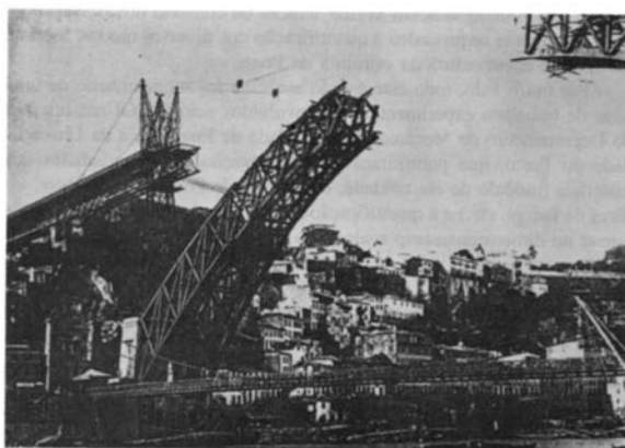
Fig. 1.3 — Fase construtiva da Ponte Luís I, impondo-se à Ponte Pênsil
