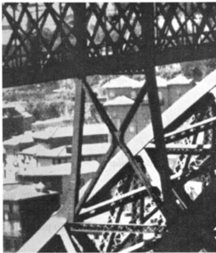
Fig. 2.10 — "Pilar PP" entre o tabuleiro superior e o arco
