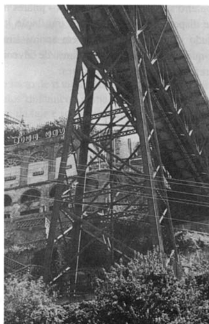
Fig. 2.9 — Pilar metálico n.º 1 situado em Gaia
