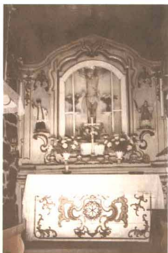
Interior da capela do Bom Jesus de Penso
