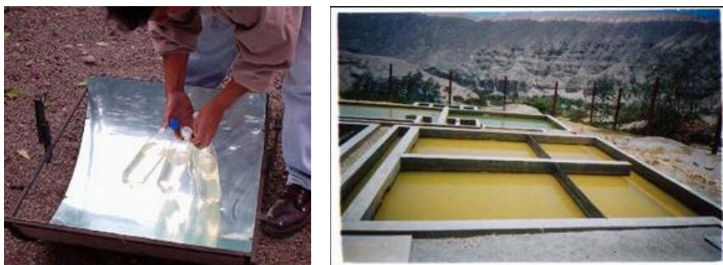
Figura 4 – Tecnologia alternativa de remoção de arsénio por oxidação solar (SORAS)
