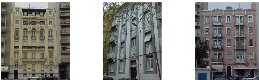
Figure 7 – Exemplos de edifícios gaioleiros.
