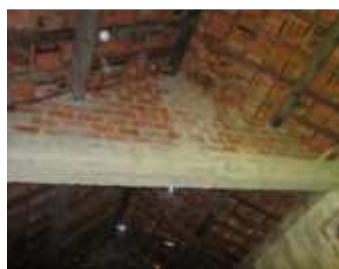
Figura 37- Asna materializada por linha em viga de betão armado com enchimento em alvenaria de tijolo, cobertura em telhado de duas águas com madres e ripado de suporte das telhas em estrutura de madeira.
