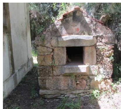
Forno com boca voltada a Sul. Tem planta quadrangular (1,4 m de lado), sendo construído em alvenaria de grauvaque.
