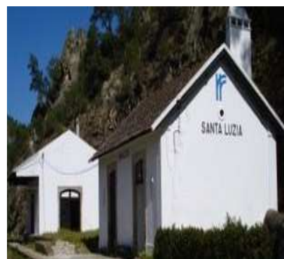
Figura 44- Armazém de carga adjacente à Estação de Santa Luzia
