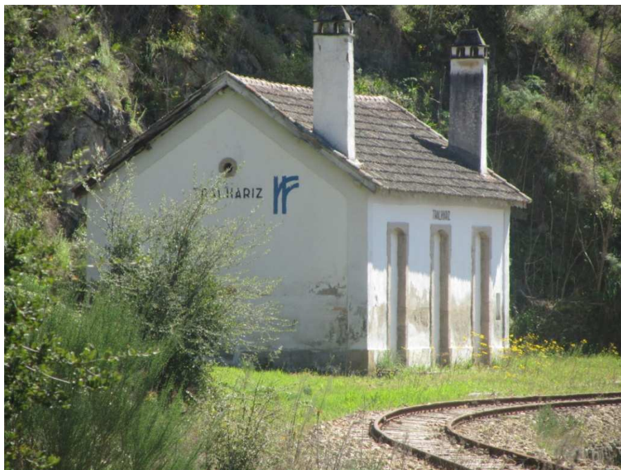
Figura 16 – Apeadeiro de Tralhariz.
