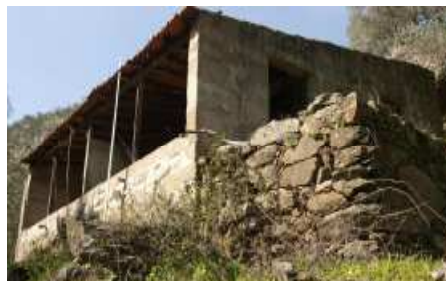
Construção de alvenaria de pedra seca, em xisto e granito, implantada num socalco.
