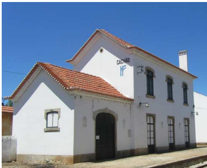
Figura 27 – Estação do Cachão.
