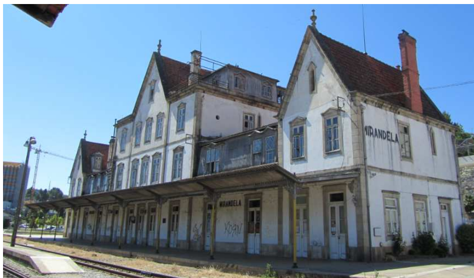
Figura 30 – Estação de Mirandela.
