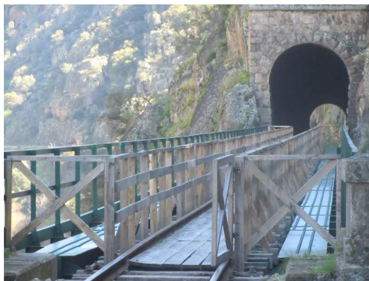
Figura 15 – Viaduto e túnel das presas, respetivamente.
