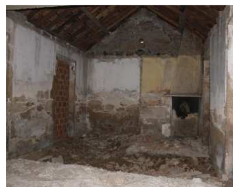
Figura 39- Alçado Sul (interior) em alvenaria de pedra, coberta por reboco de cal; apresenta também lareira adossada à parede.
