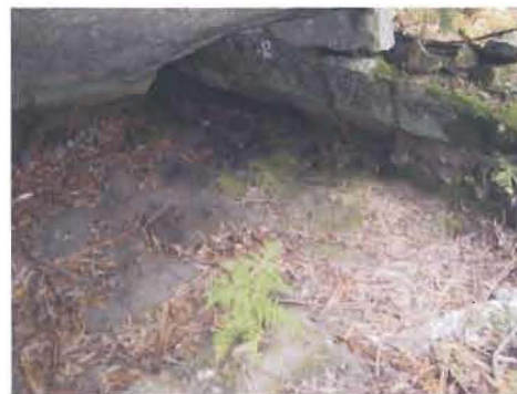
Pormenor do Abrigo de Vale Cerdeira, com muro moderno de protecção.
