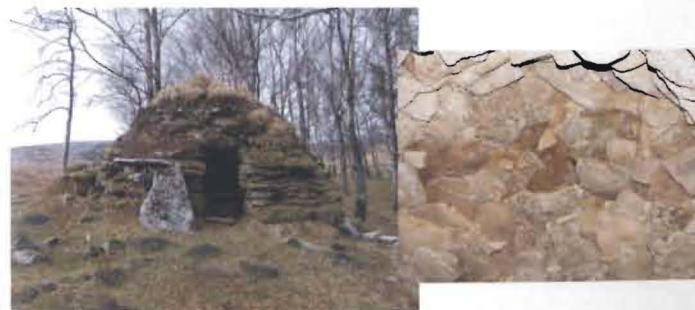
Cabana 3 do Alto dos Seixos. Perspectivo geral e pormenor do interior da abóbada.
