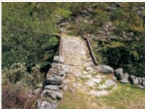
mamposteria de calhaus e blocos graníticos mal afeiçãoados. O arco apresenta um aparelho cuidado com aduelas "cúbicas" de modulação regular. O piso do tabuleiro, lajeado, assenta ao centro da ponte no
