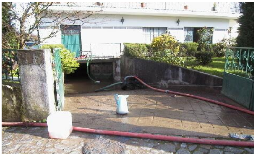
Fot. 4 - Aspecto das habitações inundadas em Celeirós (6 de Janeiro de 2001)
