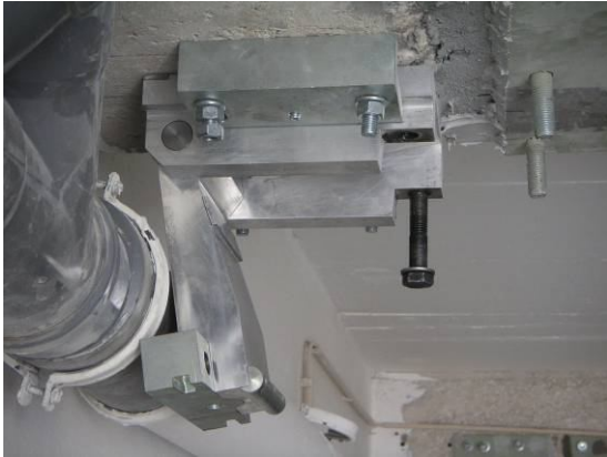
Figura 9. Ancoragem de laminados
