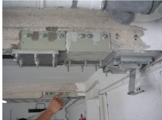
Figura 10. Adaptadores metálicos de ligação às vigas
