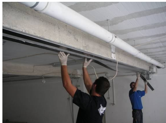
Figura 12. Aplicação dos laminados
