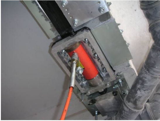
Figura 13. Montagem do sistema hidráulico
