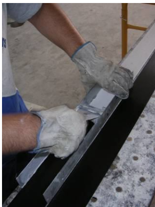
Figura 11. Aplicação de resina nos laminados
