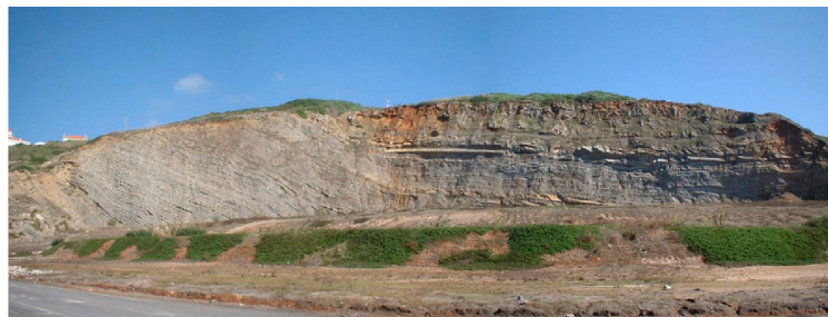
Vista panorâmica da descontinuidade (pedreira centro)
