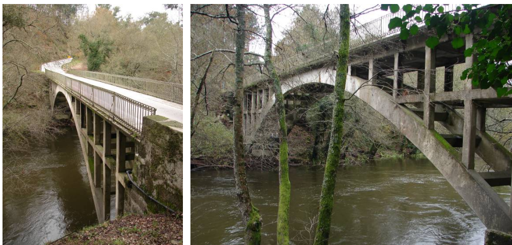
Figura 1. Vistas laterais da Ponte Luiz Bandeira (N333-3 sobre o Rio Vouga)
