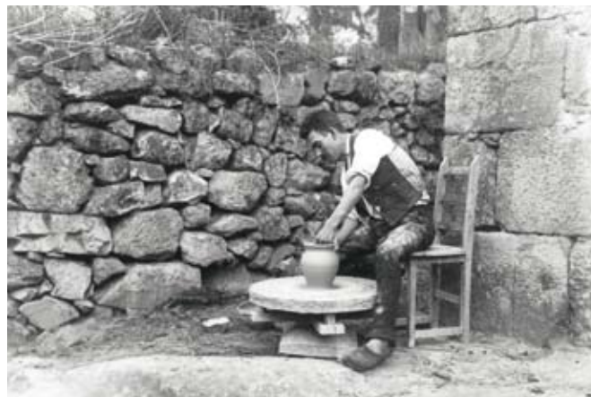
66. Oleiro de Lordelo a trabalhar à roda. Ancede (Baião, Porto). Ca. 1905. Museu Nogueira da Silva. Arq. Fotográfico de Rocha Peixoto (N.º 66). Rocha Peixoto utiliza esta fotografia no seu texto sobre «Sobrevivência da primitiva roda de oleiro em Portugal» (PEIXOTO, 1995 [1905]: 179-184, est. XXXIV, N.º 4).
