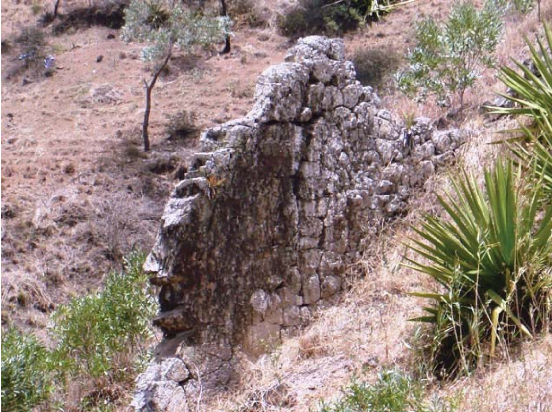
Figura 8. 21 - Filão basáltico bastante dismantelado na encosta do Pico da Antónia, ilha de Santiago. Neste filão pode-se observar, ainda, uma disjunção prismática horizontal, perpendicular às superfícies de arrefecimento.
