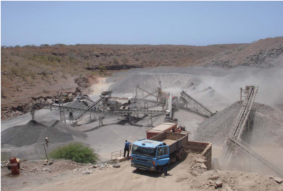
Figura 3. 4 - Exploração de inertes para a indústria de construção civil – Pedregal, ilha de Santiago, Cabo Verde.
