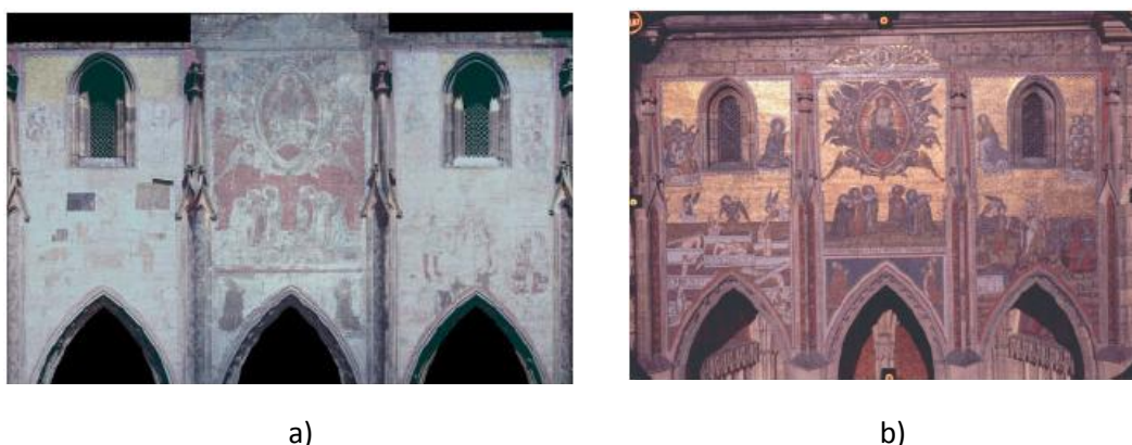
Figura 2.6. Mosaico "Juízo Final" a) antes da aplicação do revestimento baseado em materiais híbridos O-I; b) após a aplicação de materiais híbridos O-I.
