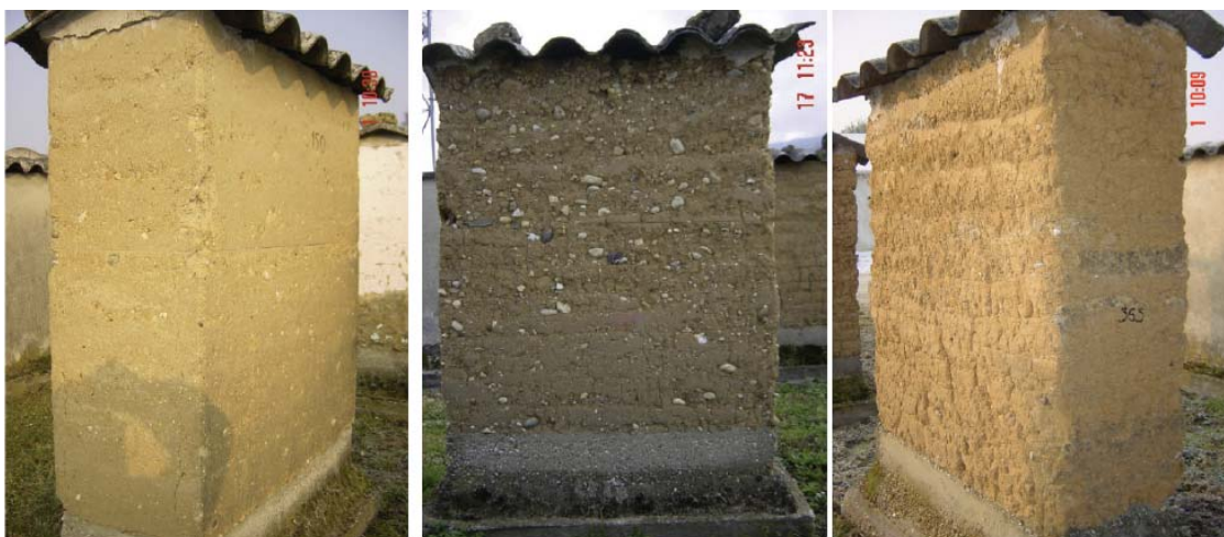
Fig.1 - Troços de paredes de taipa expostos durante 20 anos aos agentes atmosféricos: a) Parede em terra estabilizada com 5% de cal; b) Parede em terra sem estabilização (solo misturado); c) Parede em terra sem estabilização (Créditos: Bui et al., 2008, p.912).
